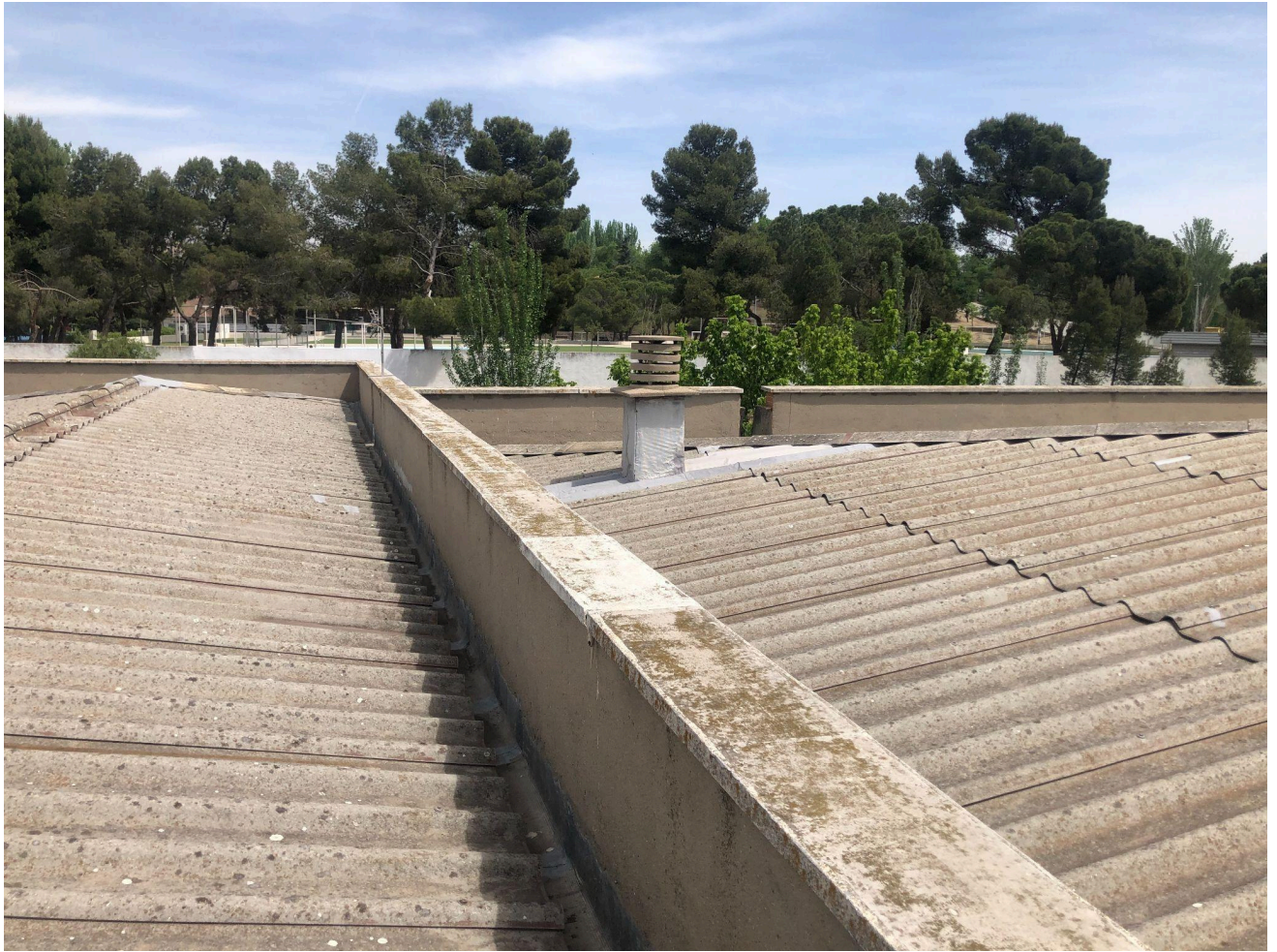
Cubiertas de fibrocemento, peto perimetral y chimenea.
