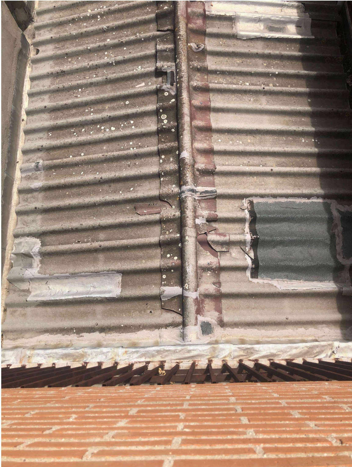
Estado general de las placas de fibrocemento.
