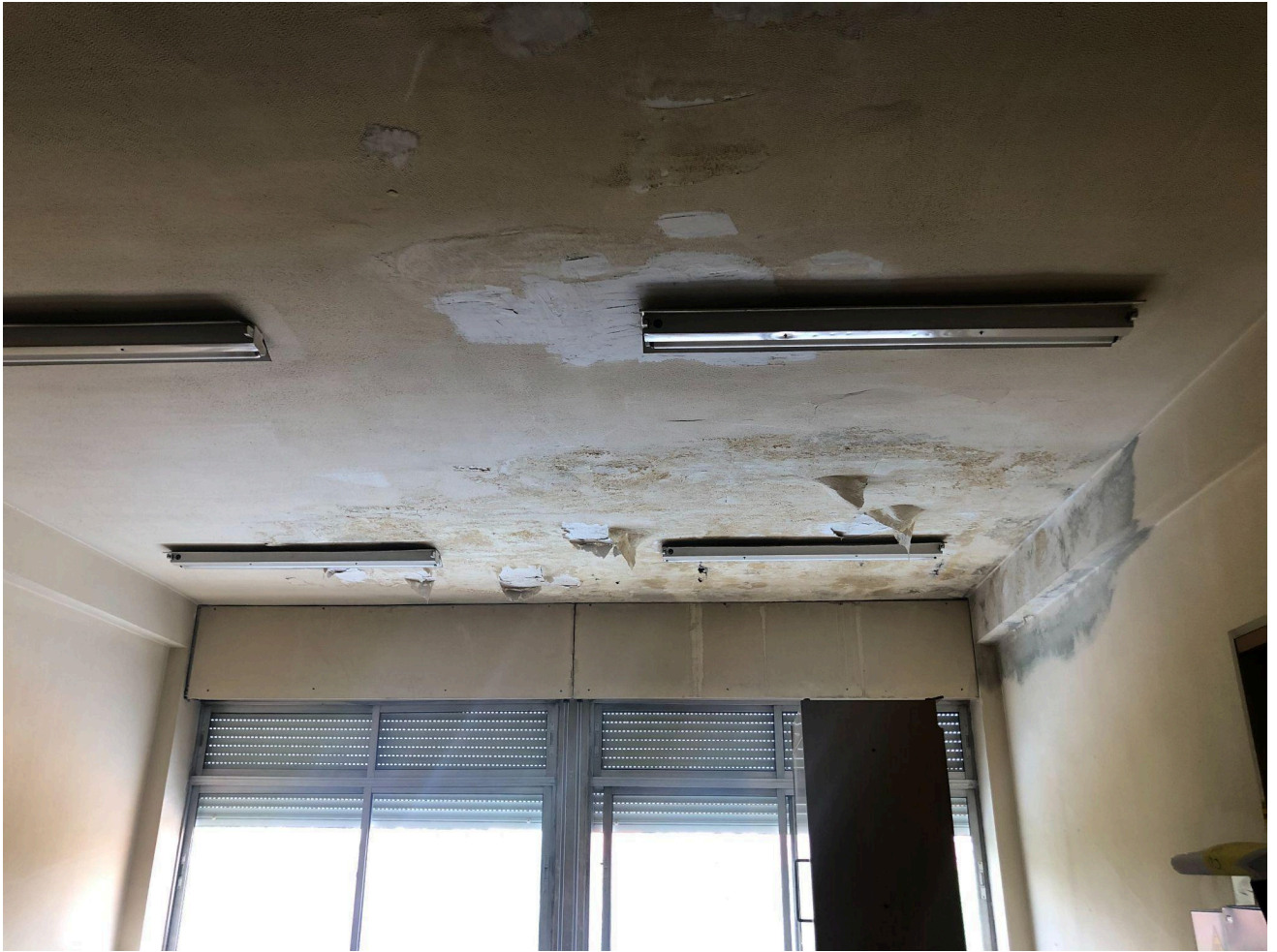
Daños provocados por la filtración de agua.
