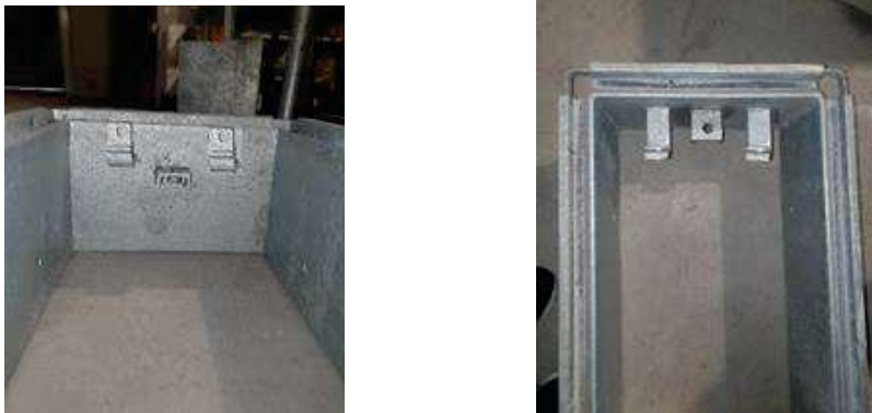
Figura 12. Sistema de cierre parte interior de la arqueta
