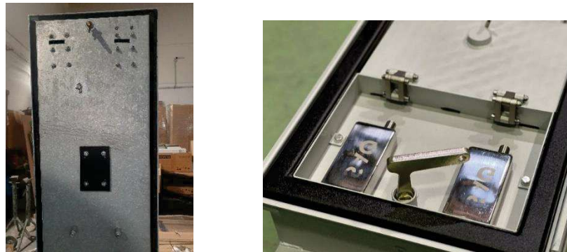
Figura 11. Sistema de cierre parte superior de la arqueta con dos candados SAG
