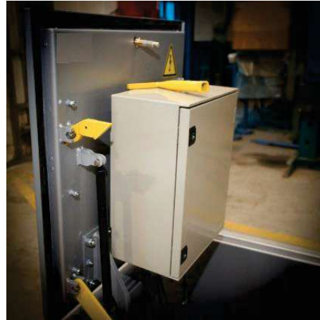
Figura 18. Detalle tapa tipo solar con cuadro de Telemetría instalado
