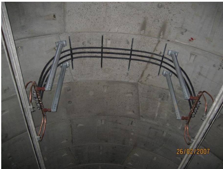
Foto 8: Elementos de línea aérea en túnel
