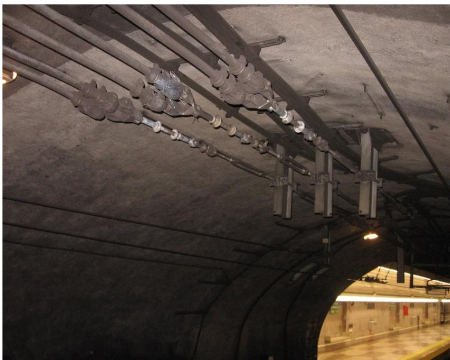
Foto 9: Elementos de línea aérea en túnel
