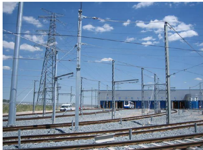
Foto 7: Vía Secundaria (pórticos funiculares) Acceso a zona de entrevía en túnel
