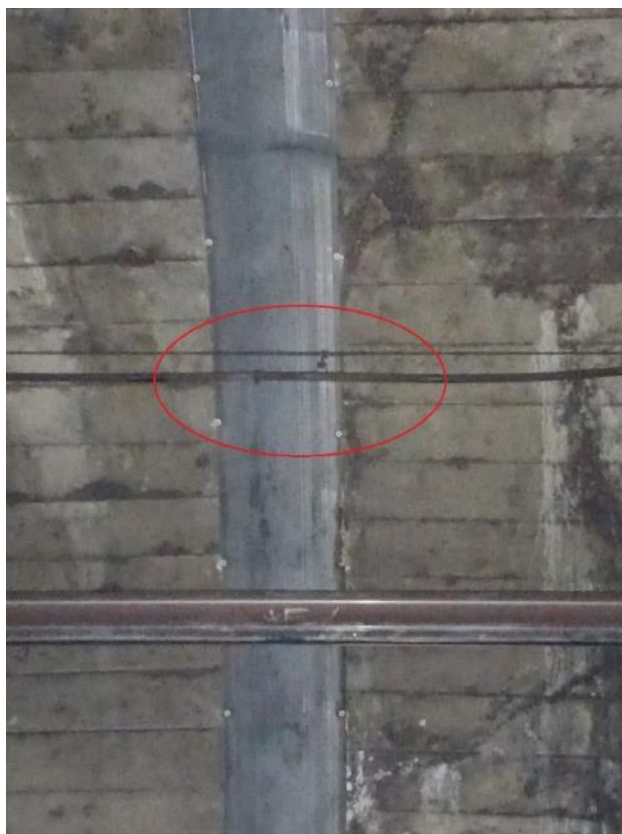
Foto Radiante antiguo suelto del fiador PK15+540
