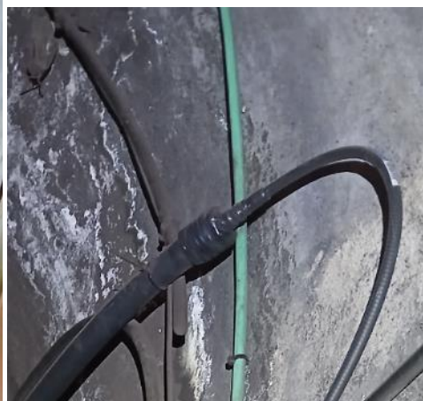
Foto tramo San Blas – Simancas detalle de cable cortado sin servicio
