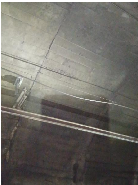
Foto Cable radiante antiguo soporte roto del fiador PK17+525
