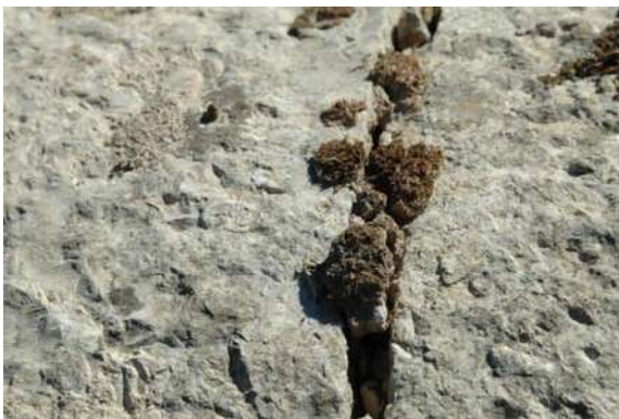
Fig. 115-119.- Rotura de piezas de sillería. Falta de material en piezas. Grietas y fisuras
