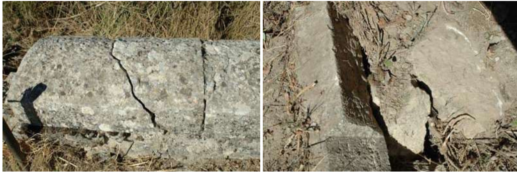
Fig. 107-114.- Rotura de piezas de sillería. Falta de material en piezas. Grietas y fisuras
