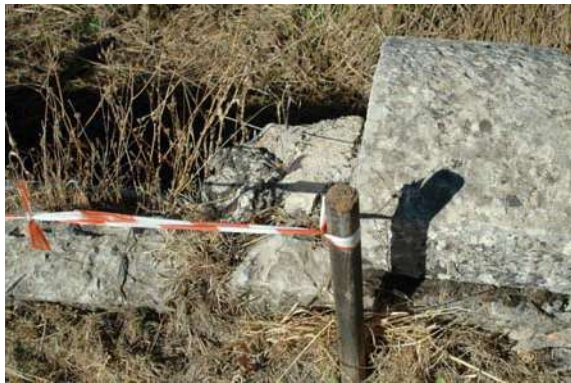
Fig. 107-114.- Rotura de piezas de sillería. Falta de material en piezas. Grietas y fisuras
