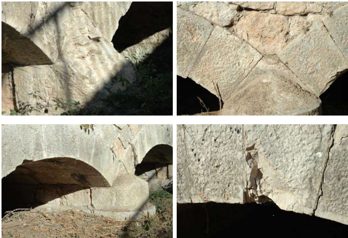
Fig. 047-050.- Vistas de las pilonas. Piezas de cantería. Buena talla. Rotura de la parte superior. Detalle piezas
