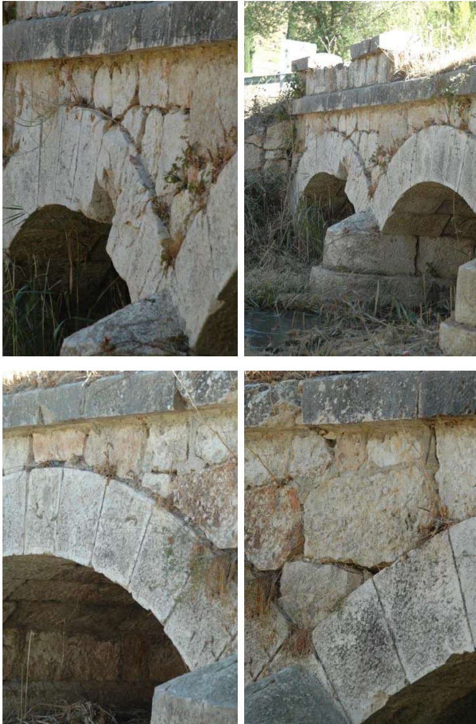
Fig. 066-069.- Vista general del deterioro generalizado de las fábricas.
