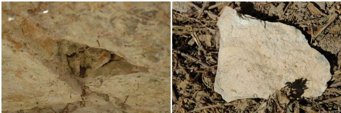
Fig. 053-054.- Daños en Intradós del arco. Detalle de pérdida de material
