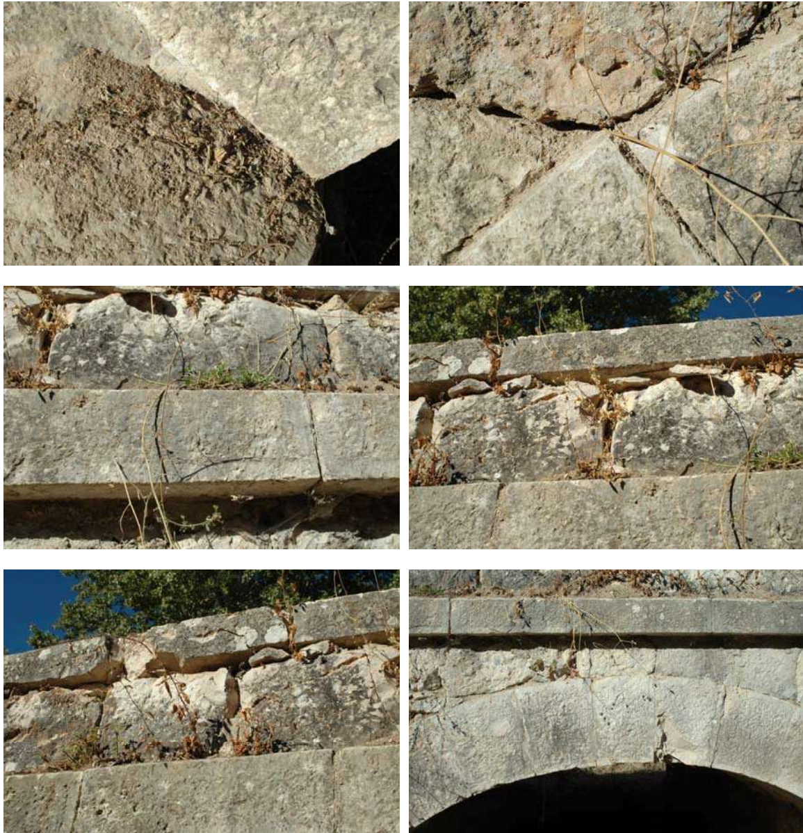
Fig. 033-038.- Vista general de los Daños en la cara Aguas Arriba donde se aprecian los detalles descritos en las fotos anteriores
