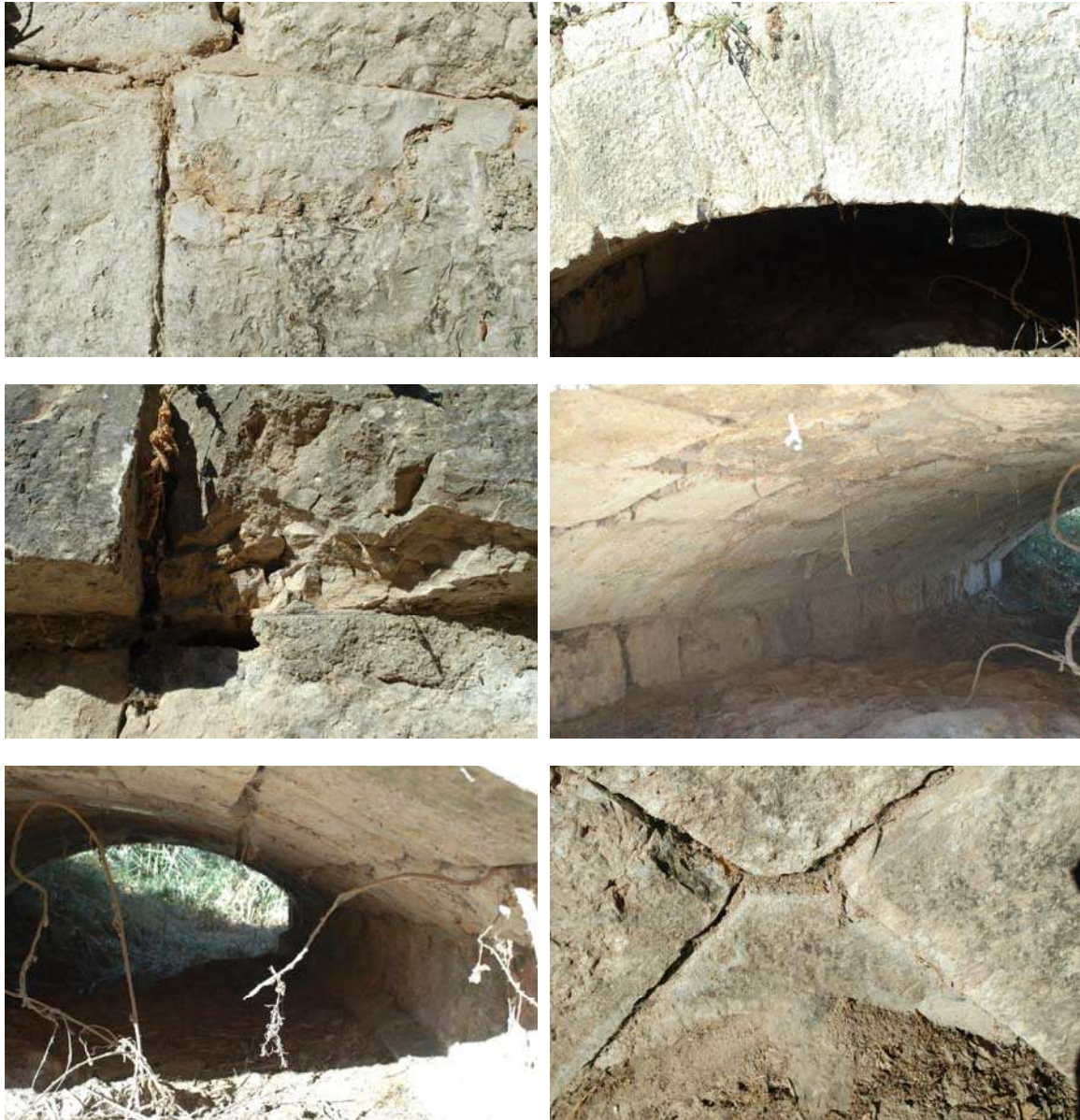
Fig. 027-032.- La fábrica de sillería trabajada se encuentra en mejor estado. Si tiene pérdidas de material en bordes. En la foto 27 se aprecian los trabajos de la bujarda
