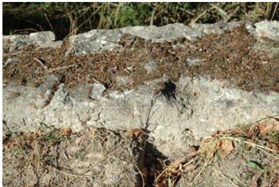
Fig. 078-099.- Detalle de la pérdida total del pretil. Piezas desprendidas, expoliadas y/o desaparecidas en su totalidad. Falta de linealidad por empuje de vehículos.
