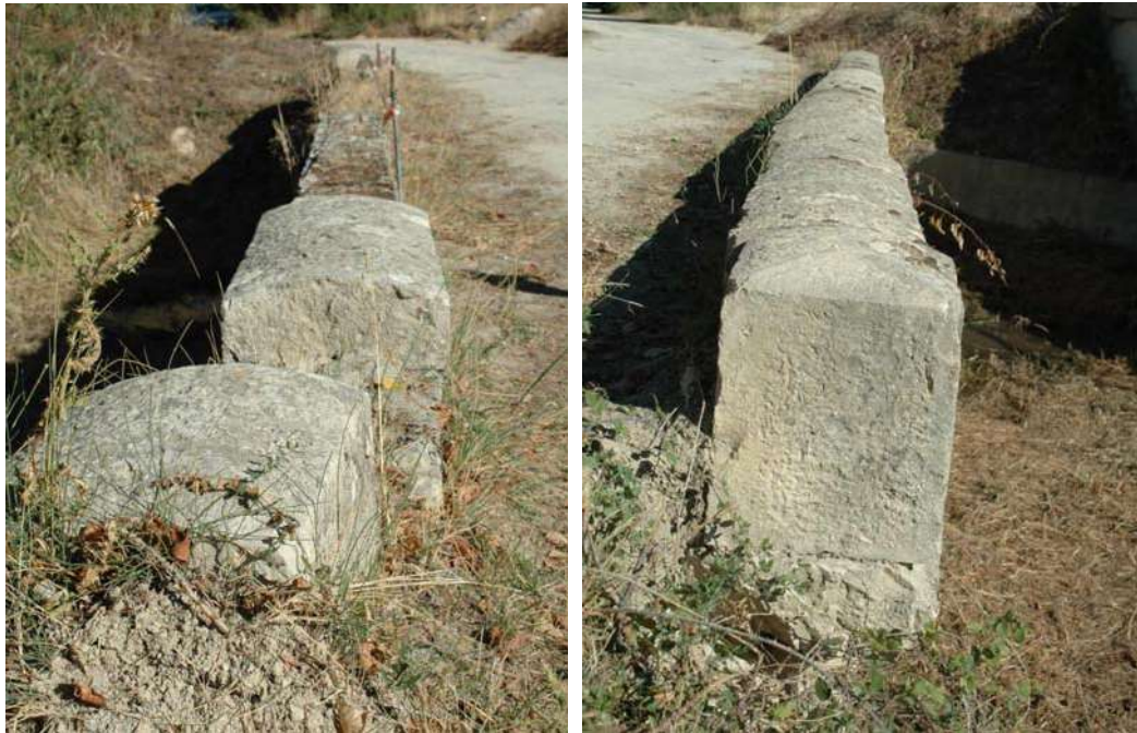
Fig. 078-099.- Detalle de la pérdida total del pretil. Piezas desprendidas, expoliadas y/o desaparecidas en su totalidad. Falta de linealidad por empuje de vehículos.
