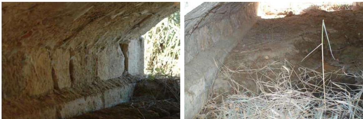
Fig. 051-052.- Intradós del arco. Detalle del lecho con acumulación de lodos
