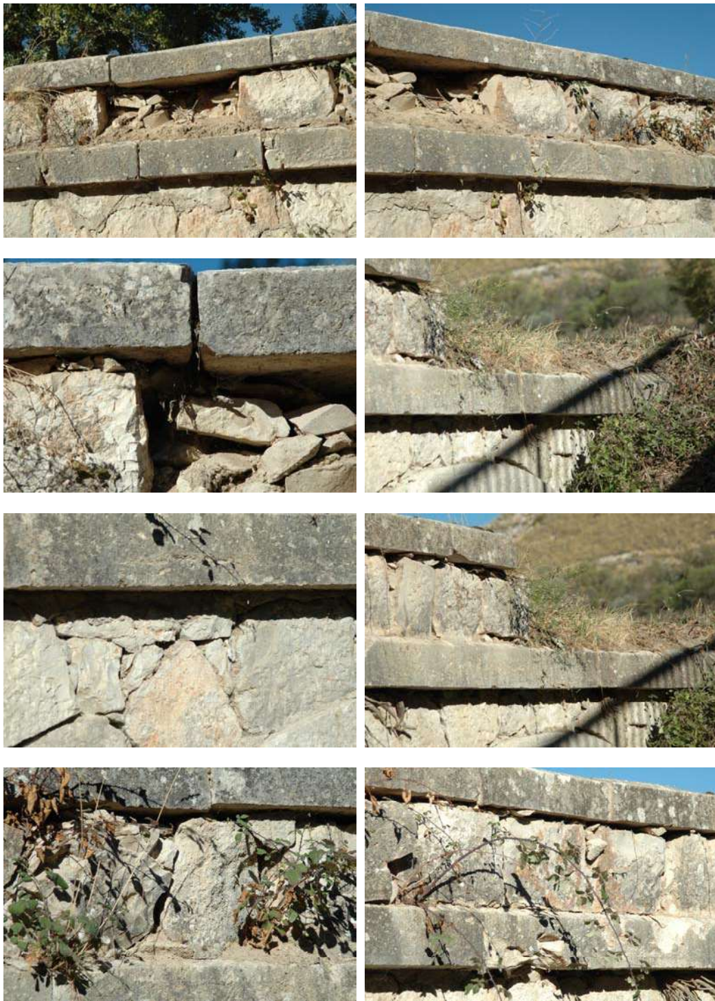
Fig. 039-046.- Vistas generales del estado del pretil. Faltas, vegetación, roturas,...
