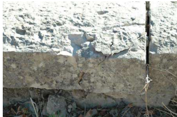
Fig. 078-099.- Detalle de la pérdida total del pretil. Piezas desprendidas, expoliadas y/o desaparecidas en su totalidad. Falta de linealidad por empuje de vehículos.
