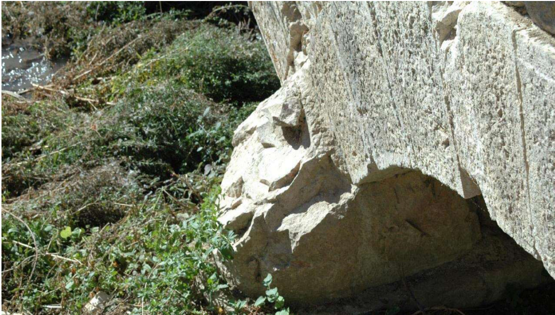
Fig. 115-119.- Rotura de piezas de sillería. Falta de material en piezas. Grietas y fisuras
