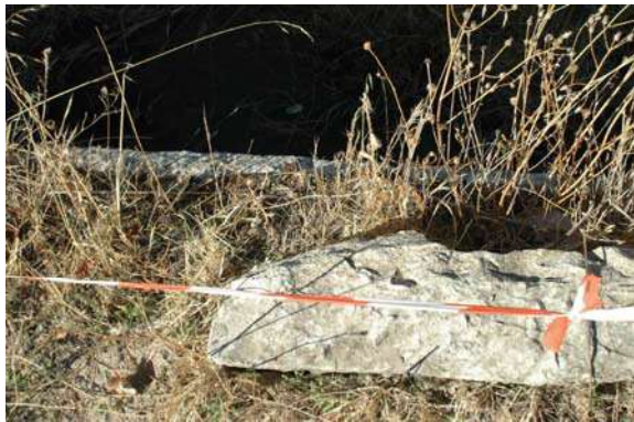
Fig. 107-114.- Rotura de piezas de sillería. Falta de material en piezas. Grietas y fisuras
