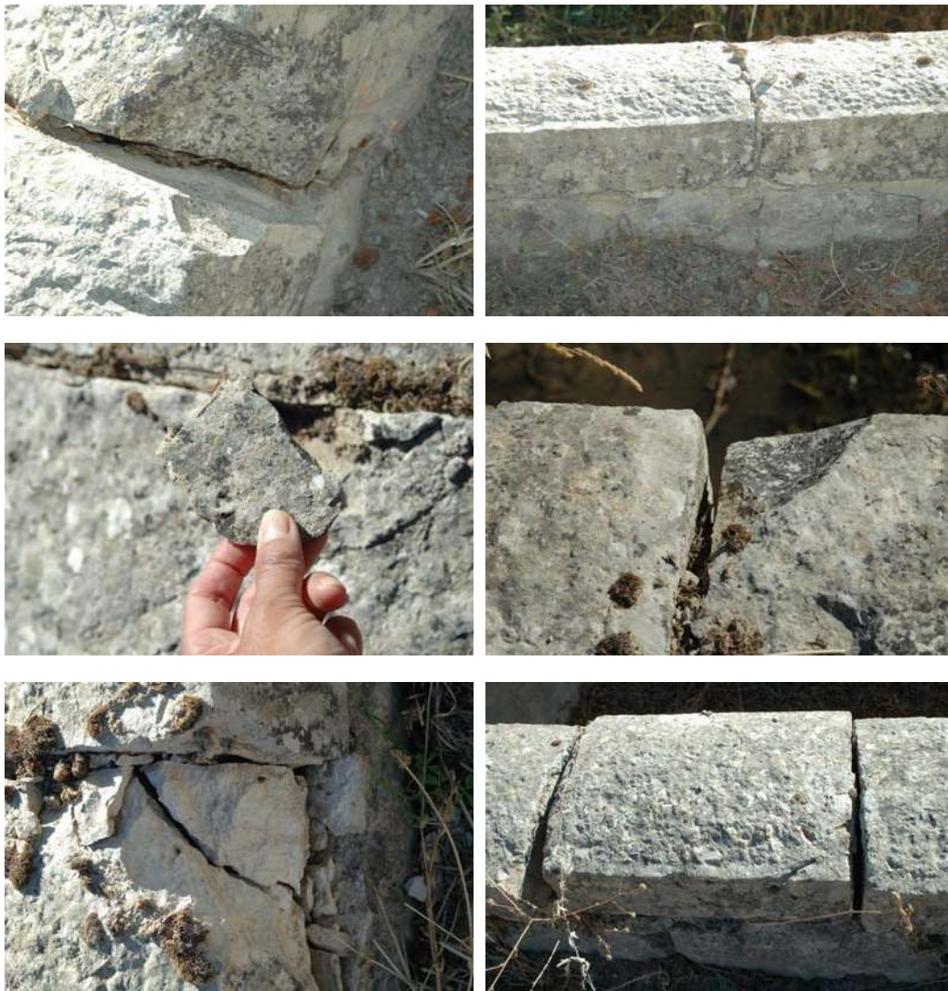
Fig. 100-106.- Rotura de piezas de sillería. Falta de material en piezas. Grietas y fisuras
