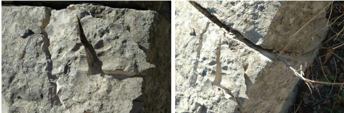
Fig. 100-106.- Rotura de piezas de sillería. Falta de material en piezas. Grietas y fisuras
