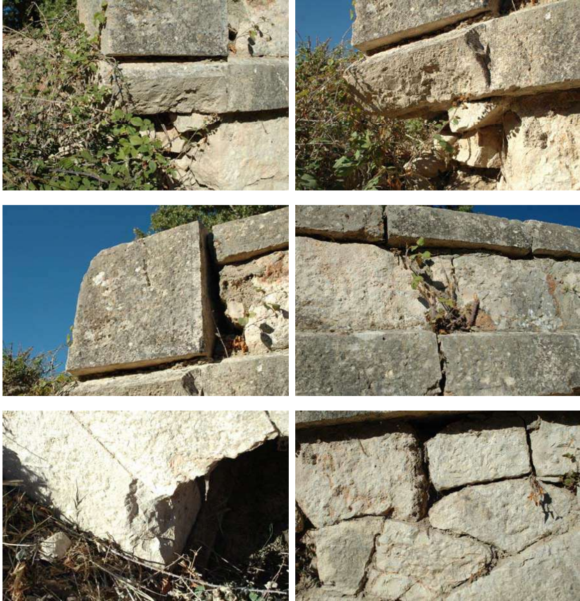
Fig. 015-016.- Arranque del Estribo en lado Izquierdo aguas arriba. El resto del estribo ha desaparecido.
