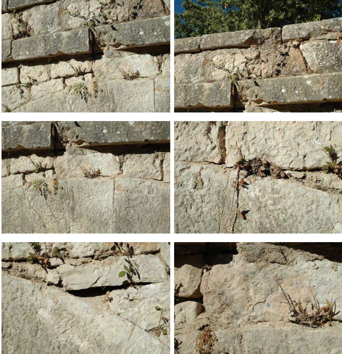
Fig. 021-026.- La fábrica de sillarejo se encuentra invadida por la vegetación (en concreto zarzas. Esta penetra en las juntas y expulsa las piezas de menor entidad. El mortero entre piezas se encuentra perdido o arenizado. Bastantes restos de vegetación.
