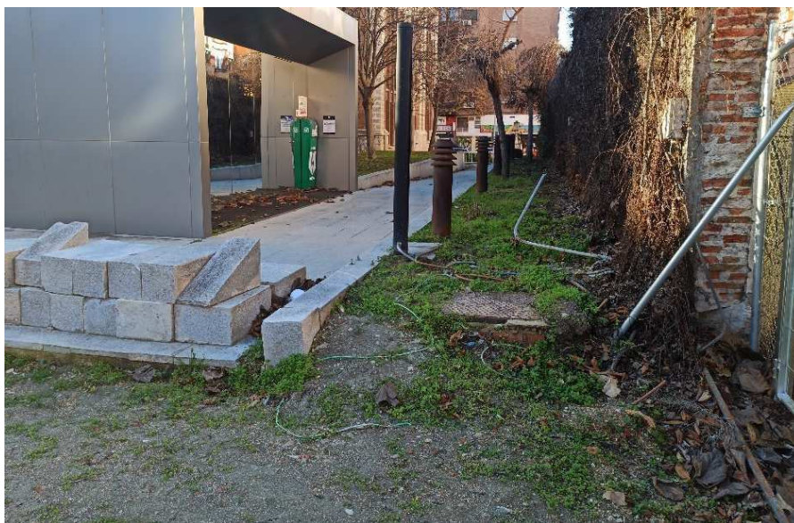
Zona a rematar con pizas de sillería de granito para cierre de jardinera
