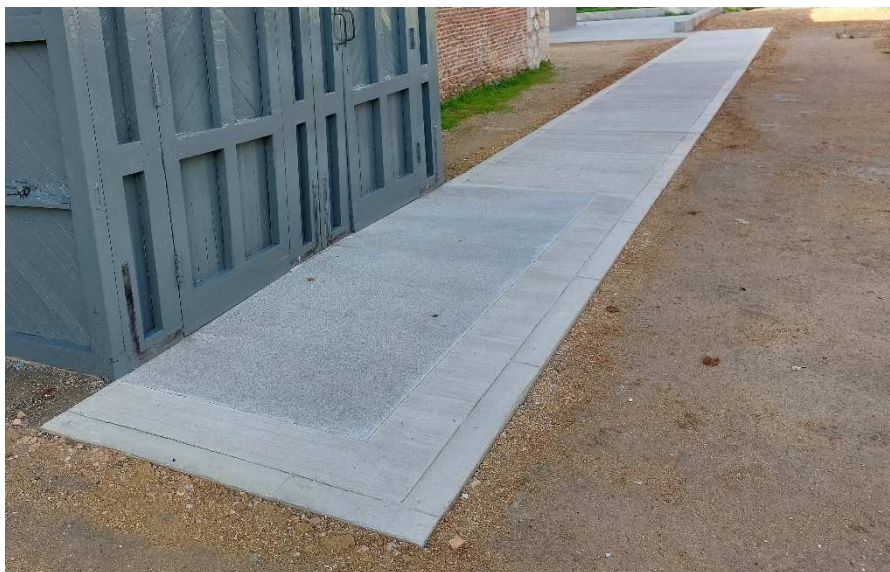
Solera provisional de acceso a la Nave de Motores y baldosas de granito a retirar
