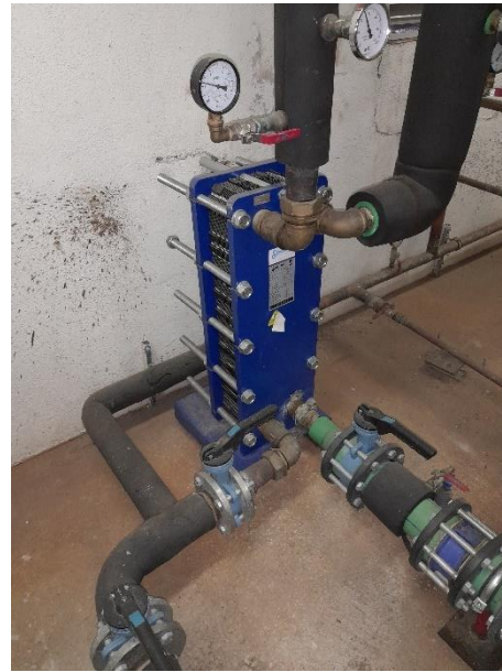
Intercambiador solar Sedical modelo UFP-54/48mh 243kW
