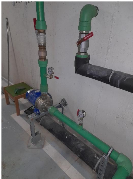
Bomba cloración BC EBARA DWC N/I 300 1,1kW 14.000 l/h 1 bar
