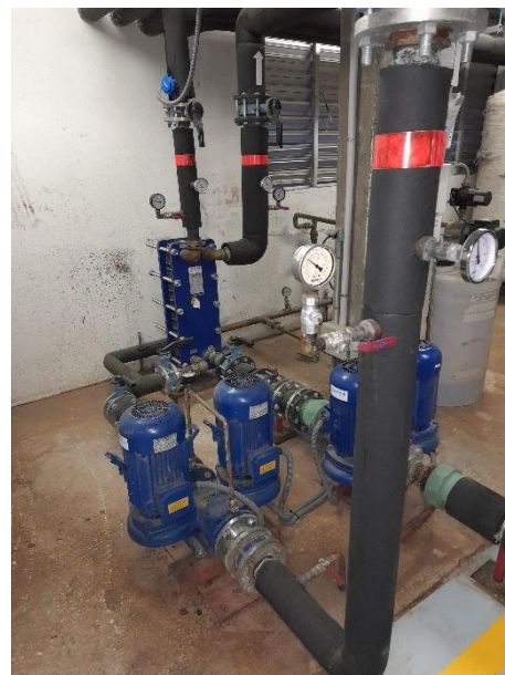
Intercambiador solar Sedical modelo UFP-54/48mh 243kW
