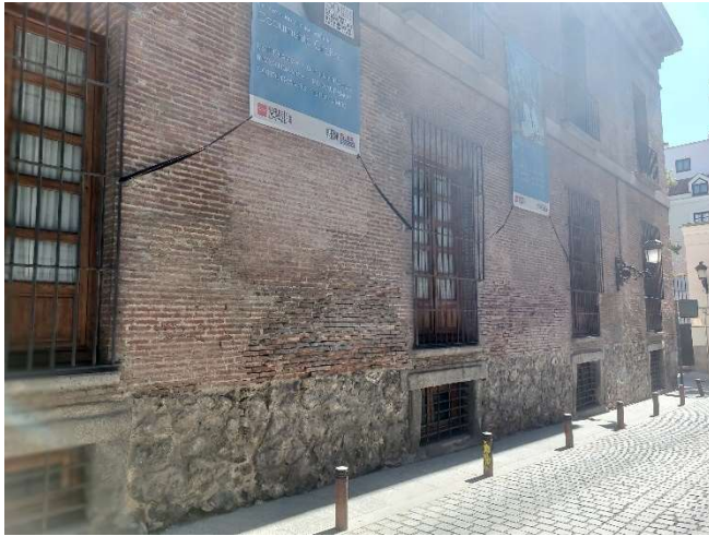
Piezas de ladrillo rotas o caídas en fachadas exteriores (izquierda C/G. Rolland y dcha. C/ La Bola)
