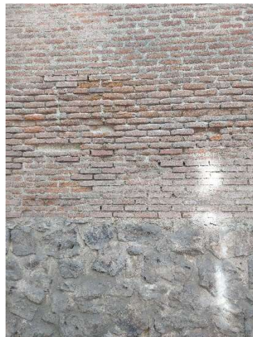
Paramentos de ladrillo en mal estado C/Guillermo Rolland
