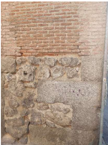
Paramentos de ladrillo en mal estado C/Guillermo Rolland
