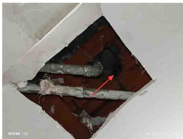
Photo 4 Se observa tubería de desagüe anulada por posible avería antigua ya reparada
