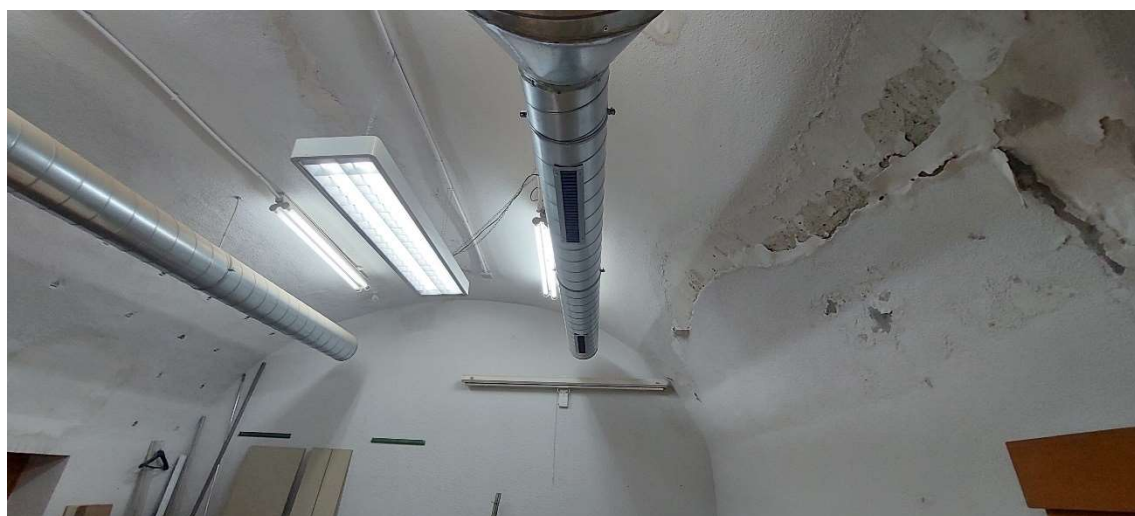
Aula de Volumen. Humedades en muro intermedio. Es el mismo muro que el del aula de Moldes y Repr.
