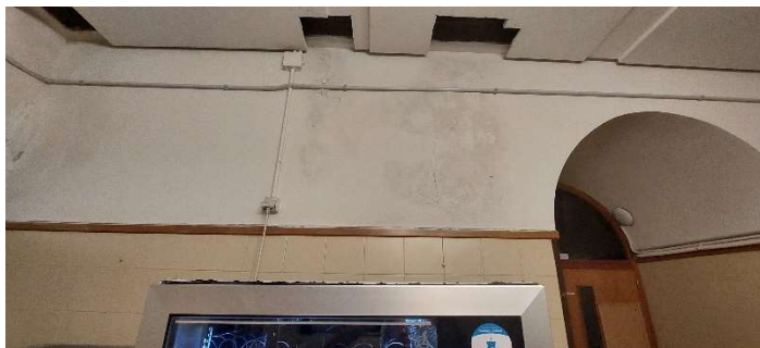
Humedades en vestíbulo principal de Pl. Sótano coincidentes con muro de carga intermedio
