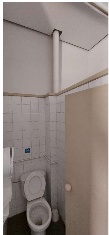
Bajante entre cabinas de aseo masculino
