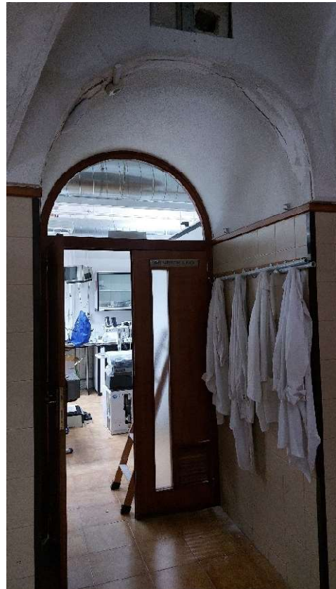
Imágenes de entrada al laboratorio de química. Humedades y desperfectos techo abovedado de entrada
