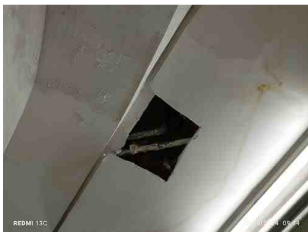
Photo 3 Daños por humedad en techo de baños, procedentes de los baños en planta superior, daños secos, posible avería ya reparada
