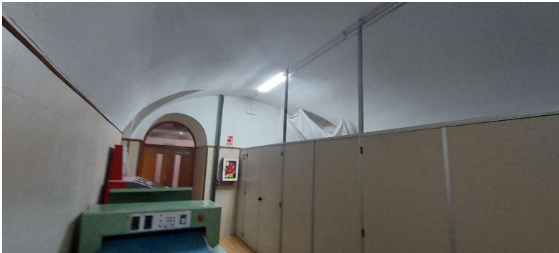
Imágenes de entrada al laboratorio de química. Humedades y desperfectos techo abovedado de entrada
