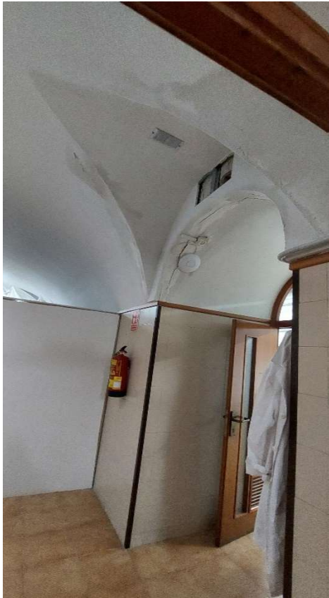
Imágenes de entrada al laboratorio de química. Humedades y desperfectos techo abovedado de entrada
