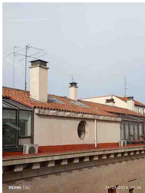
Photo 46 Inspección de canalones, material PVC no se detecta anomalía Posible filtración por caperuzas en chimeneas
