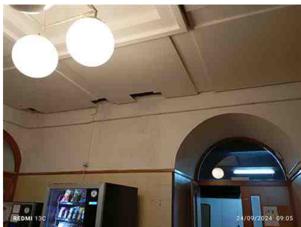
Photo 1 Humedades en paredes y techos planta baja
