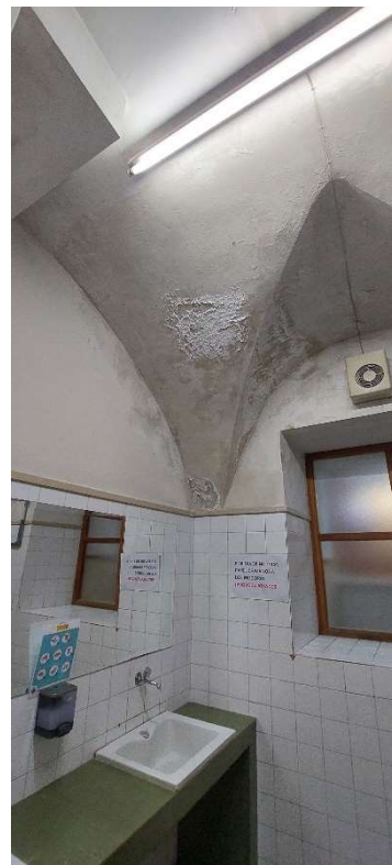
Humedades en vestíbulo principal de Pl. Sótano coincidentes con muro de carga intermedio
