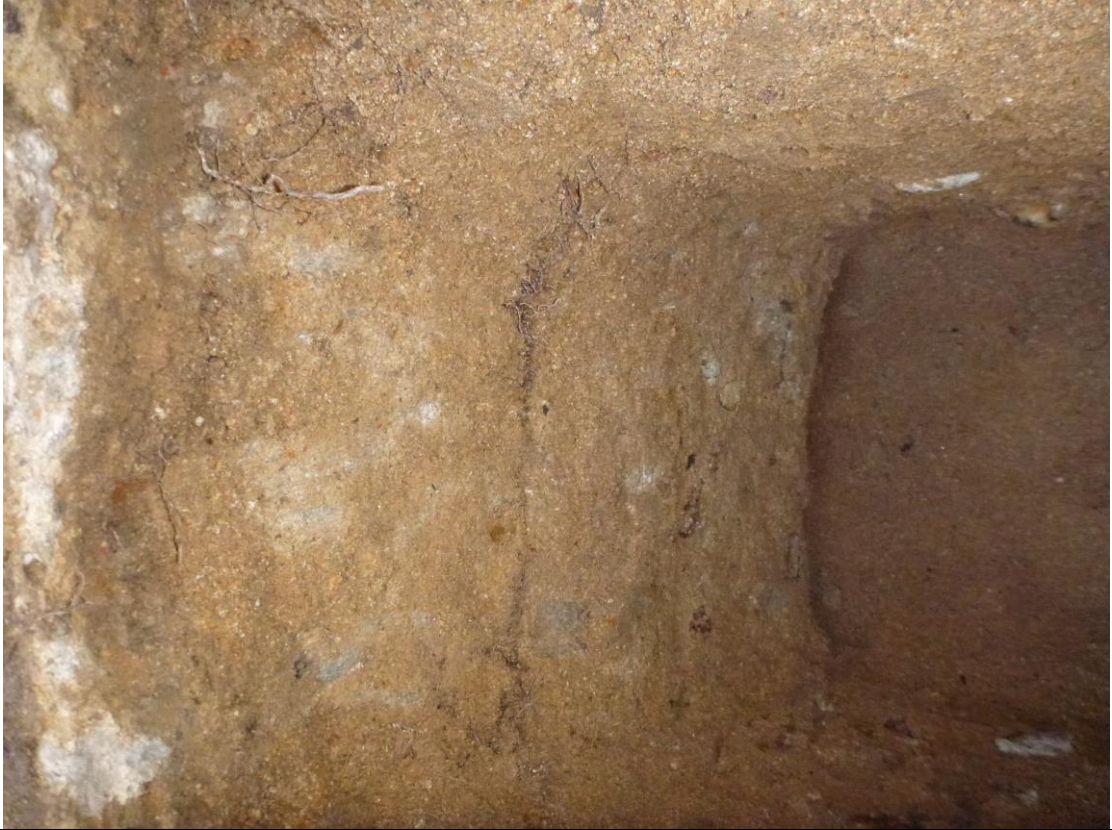
FOTOGRAFÍA 06. Calicata CC.03. Fondo de excavación. Apoyo de zapata.
