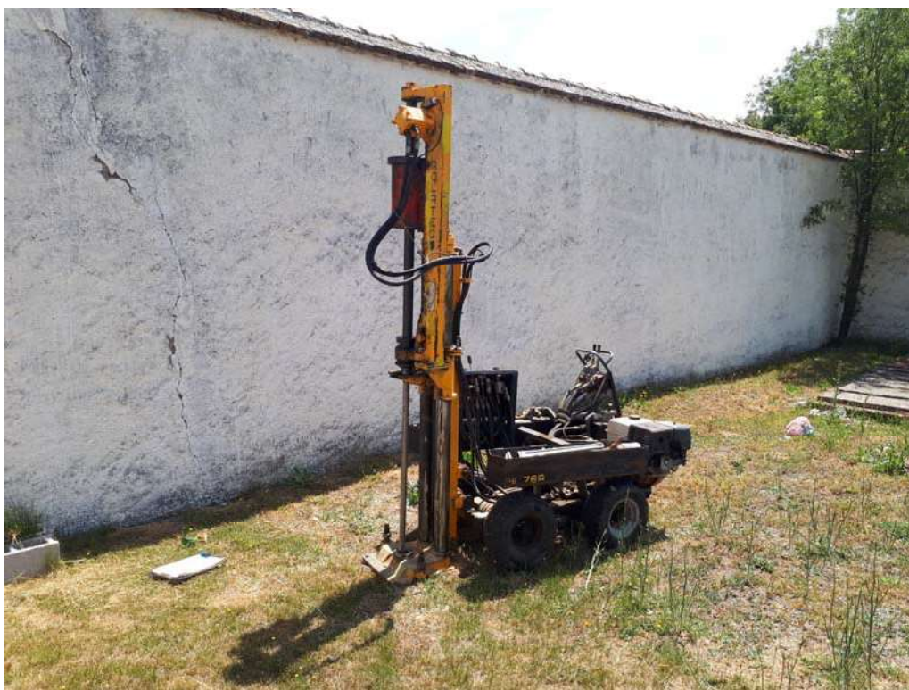
Fotografía 1: Realización del sondeo mecánico S-1.
