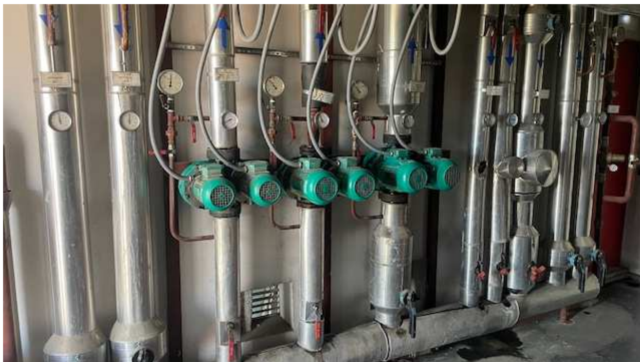
Foto 2 Colectores de ida y retorno y bombas de recirculación de circuitos fancoils
