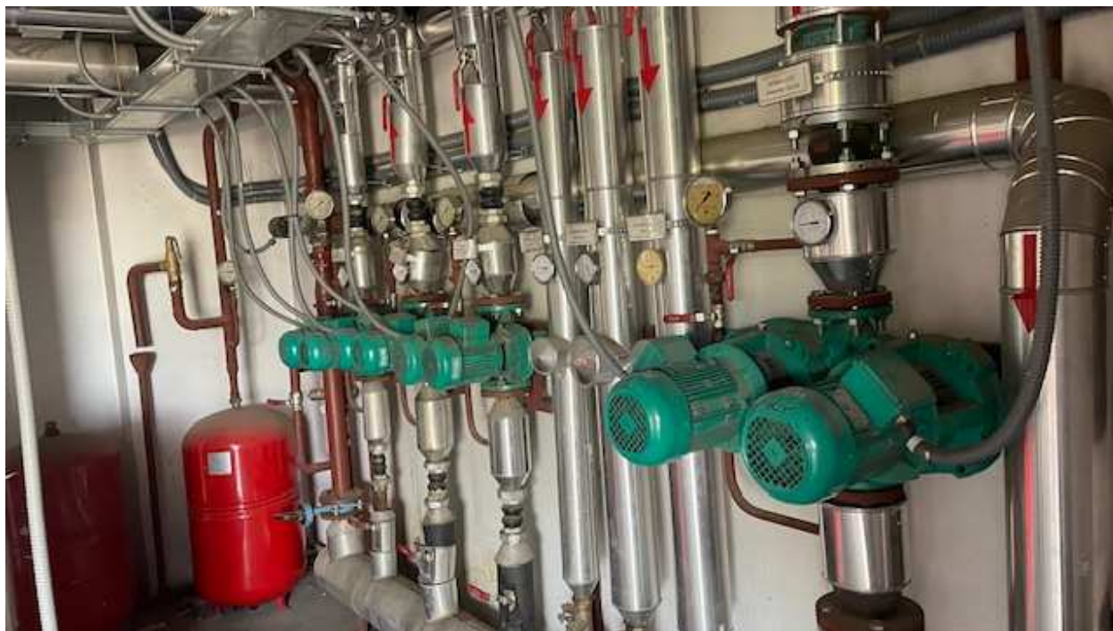
Foto 4 Circuitos de calderas y distribución de agua caliente para calefacción
