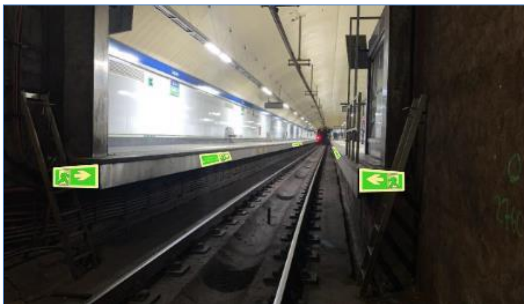
Fig. 25 – Disposición carteles evacuación plataforma de vía (I)
