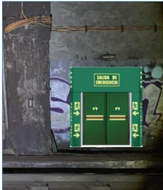
Fig. 28 – Pórtico retroiluminado en salida de emergencia
