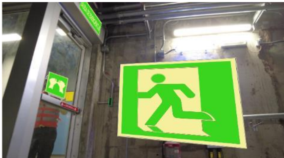
Fig. 27 – Disposición carteles en puerta evacuación de vía a andén
