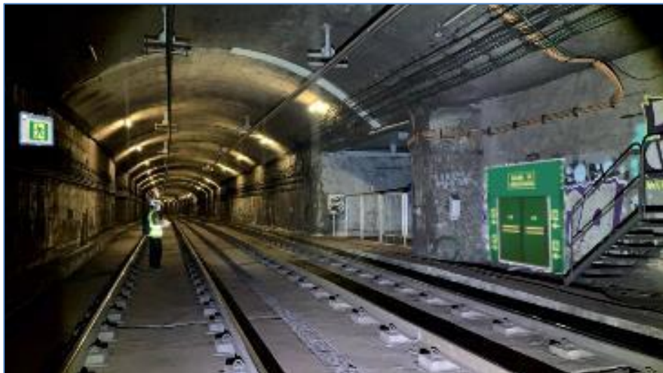
Fig. 29 – Cartel retroiluminado + pórtico salida de emergencia
