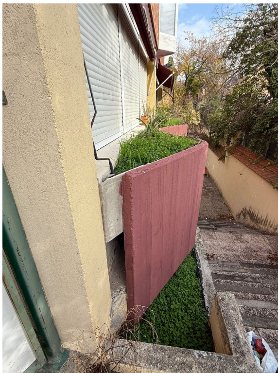
FOTO 05_ DETALLE DETERIORO DEL PANEL PREFABRICADO EN JARDINERAS.
