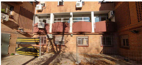
SUSTITUCIÓN PANEL PREFABRICADO DE LAS TERRAZAS
