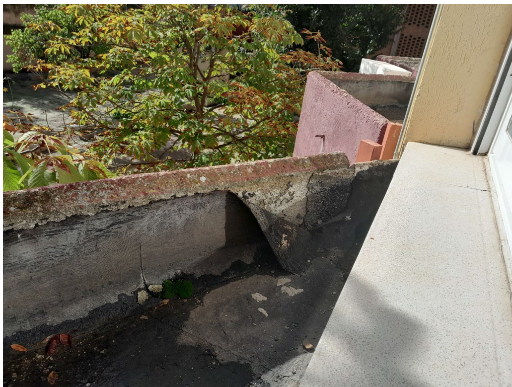
FOTO 06_ DETALLE DETERIORO DEL PANEL PREFABRICADO EN JARDINERAS. Vista de jardinera en la que se aprecia el deterioro del panel prefabricado. El mal estado de la impermeabilización produce humedades al interior.
