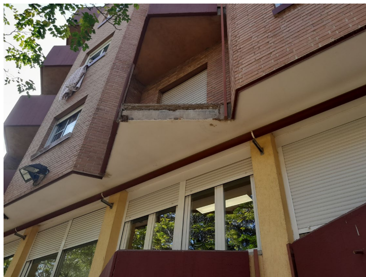
FOTO 02_ DETALLE DESPRENDIMIENTO PANEL PREFABRICADO EN TERRAZA. Vista de terraza en la que se produjo el desprendimiento del panel prefabricado. Se aprecia la placa de sujeción del panel oxidada.
