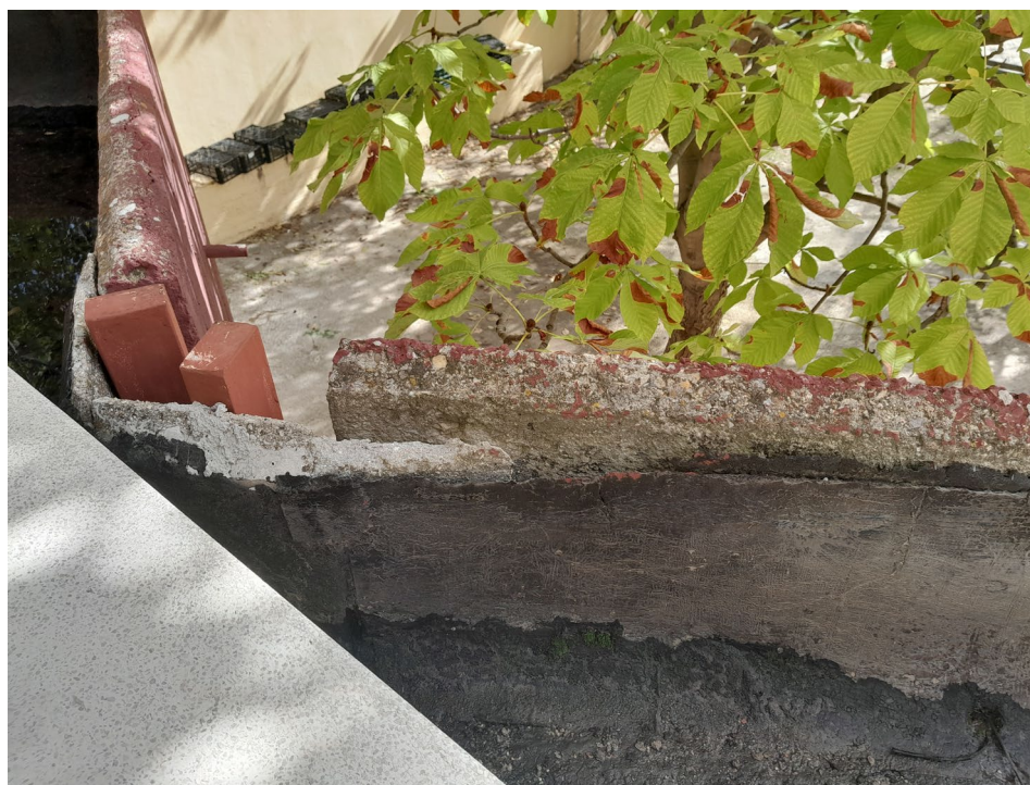
FOTO 04_ DETALLE DETERIORO DEL PANEL PREFABRICADO EN JARDINERAS. Vista de jardinera en la que se aprecia el deterioro del panel prefabricado. El mal estado de la impermeabilización produce humedades al interior.
