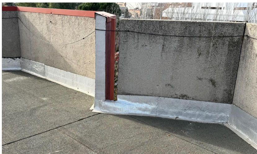
FOTO 09_ DETALLE PETO DE PANEL PREFABRICADO EN CUBIERTA Para evitar desprendimientos de paneles, se propone su sustitución por peto de ladrillo, enfoscado y pintado en color similar al resto de la fachada. El mal estado de la impermeabilización produce humedades al interior.
