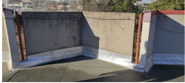
C-1: PETOS PREFABRICADOS DE CUBIERTA A SUSTITUIR
