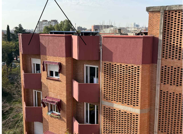
C-1: PETOS PREFABRICADOS DE CUBIERTA A SUSTITUIR
