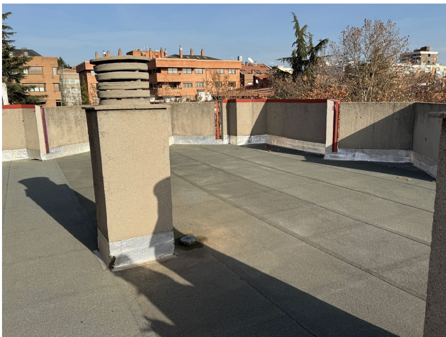
FOTO 08_ DETALLE DETERIORO IMPERMEABILIZACIÓN EN CUBIERTAS. El mal estado de la impermeabilización produce humedades al interior.
