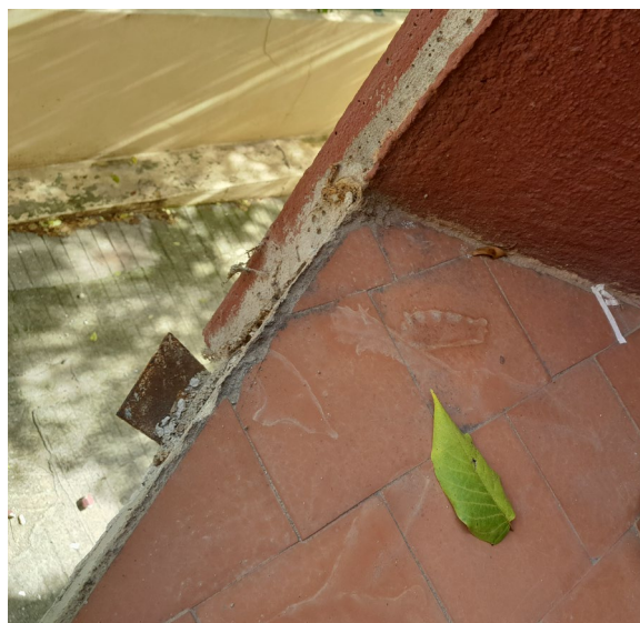
FOTO 01_ DETALLE DESPRENDIMIENTO PANEL PREFABRICADO EN TERRAZA. Vista de terraza en la que se produjo el desprendimiento del panel prefabricado. Se aprecia la placa de sujeción del panel oxidada.
