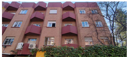
SUSTITUCIÓN PANEL PREFABRICADO DE LAS TERRAZAS EN FACHADA NORTE
