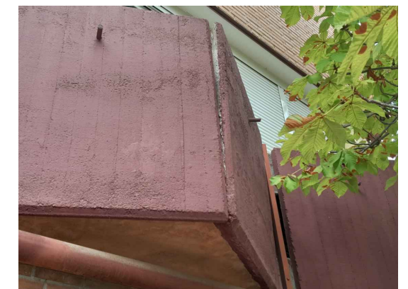
DESPRENDIMIENTO DE PANEL PREFABRICADO
