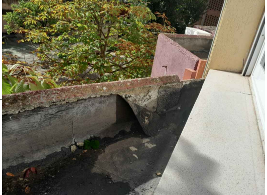
J-1: PETOS PREFABRICADOS DE JARDINERAS A SUSTITUIR
