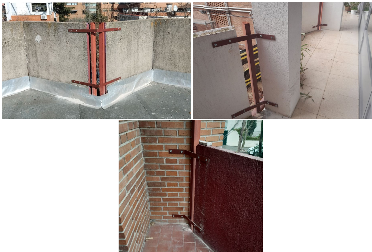
FOTO 03_ DETALLE PLETINAS EN PETOS MEDIDA DE SEGURIDAD. Se deberán desmontar las pletinas que se han instalado como medida de seguridad tanto en los paneles de las terrazas como en los petos de la cubierta.
