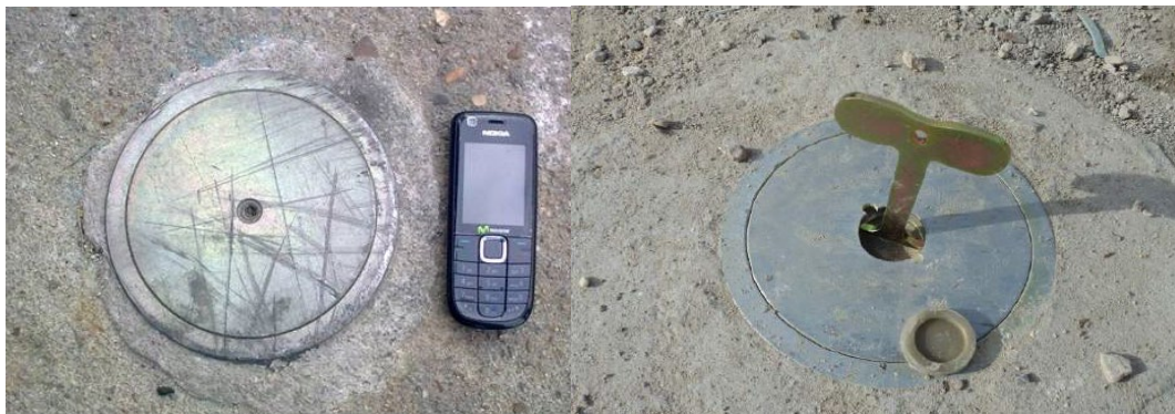
Figura 1. Detalle de tapas metálicas y sistema de apertura (izquierda allen, derecha sistema Juferma®)
