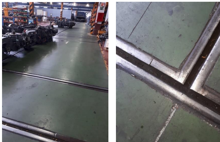
Huecos de vía embutida con una anchura aproximada de 4 centímetros
