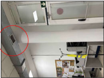
IMAGEN 07. Reprografía. Actuaciones: Retirada de rejilla para nueva ubicación. Sellado de conducto.
