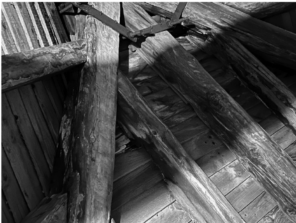
Lima bordón suroeste, pares de faldón oeste y ripia afectados por las filtraciones de cubierta.
