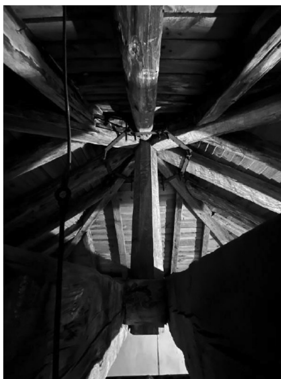
Planos de cubierta sobre nabo y apoyo de este sobre tirantes.
