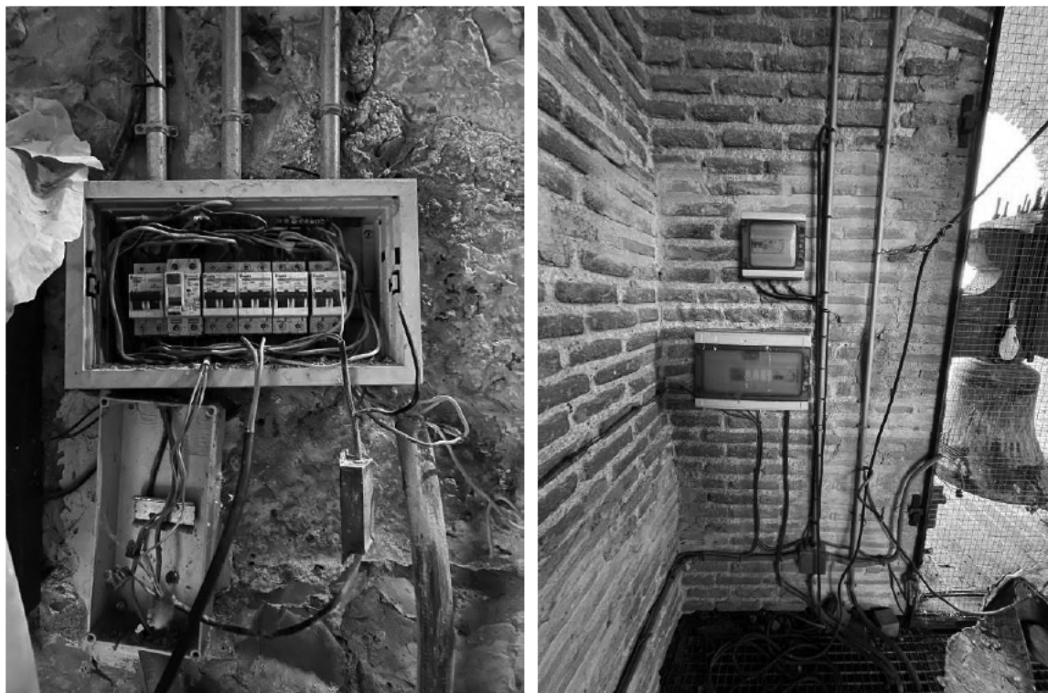
Cuadro eléctrico principal y cuadros secundarios de campanario con detalle de luminaria sobre enrejado de protección.
