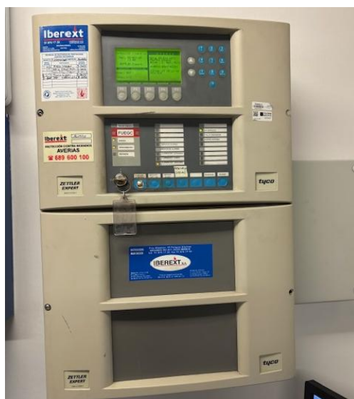
Ilustración 4. Detalle de la central de incendios existente.
