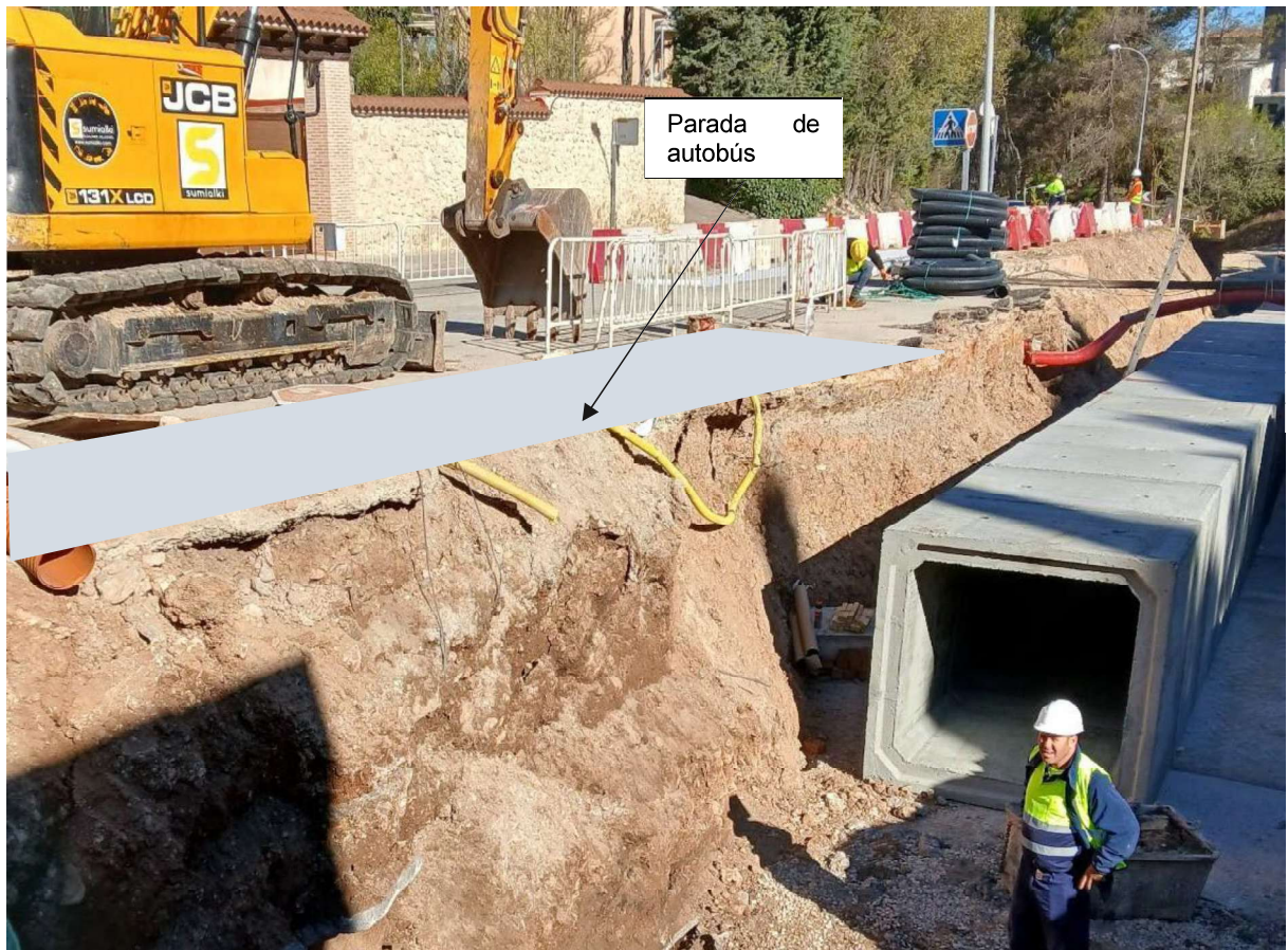
Imagen 5. Talud vertical de excavaciones entre el paso N.º 5 y N.º 6
