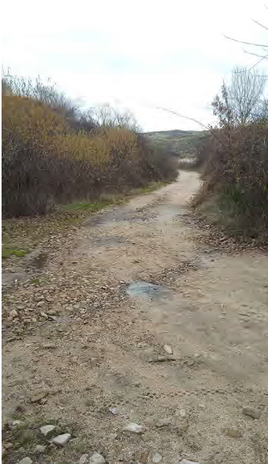
Vista de la erosión existente en el camino en el cruce con el arroyo de la Canaleja
