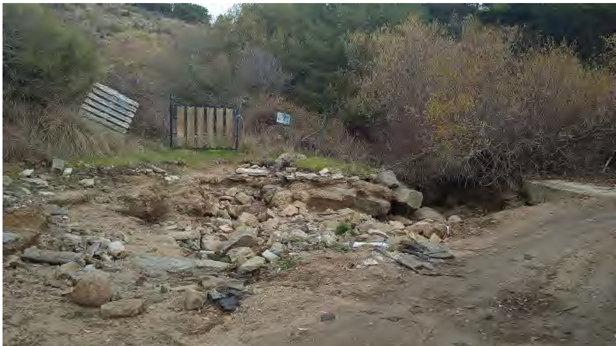
Vista de la erosión del camino en la margen derecha del arroyo Chubieco a la entrada del puente
