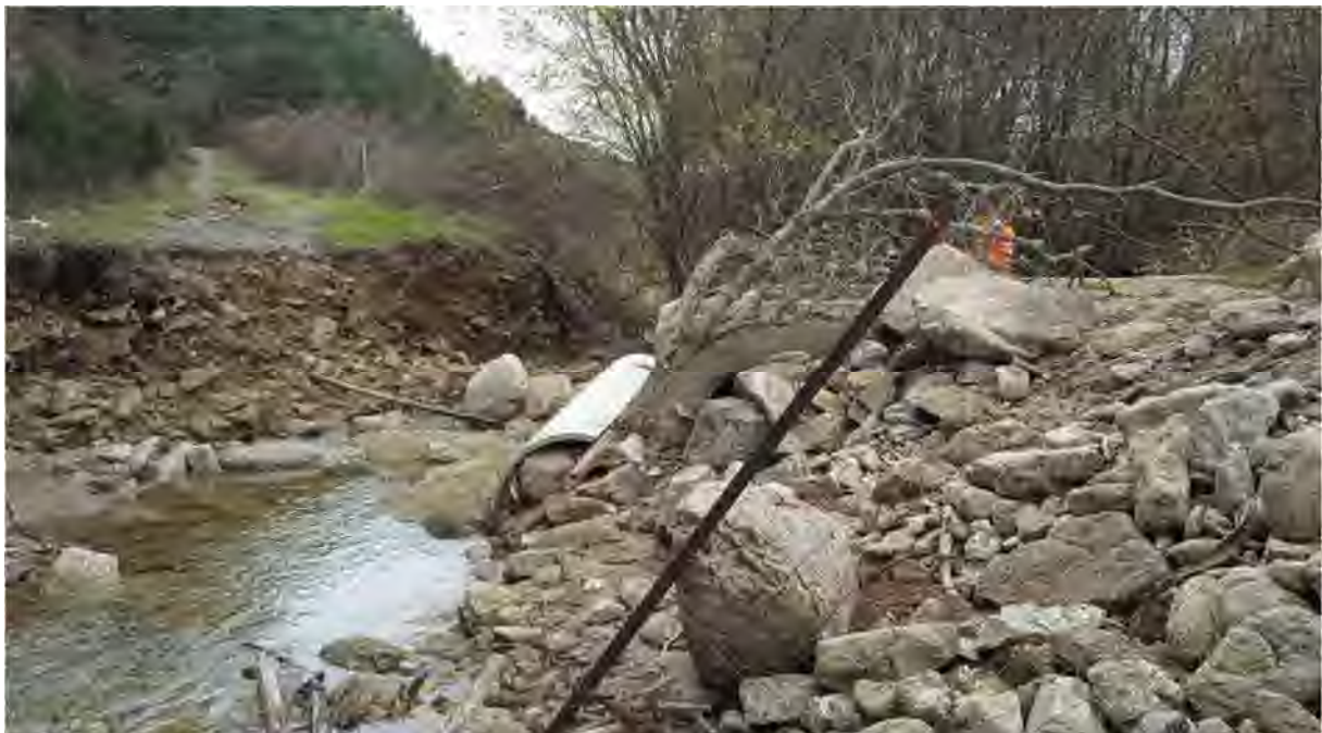
Vista de la margen izquierda del arroyo Navalacuerda desde aguas arriba. ODT multitubo existente totalmente aterrada
