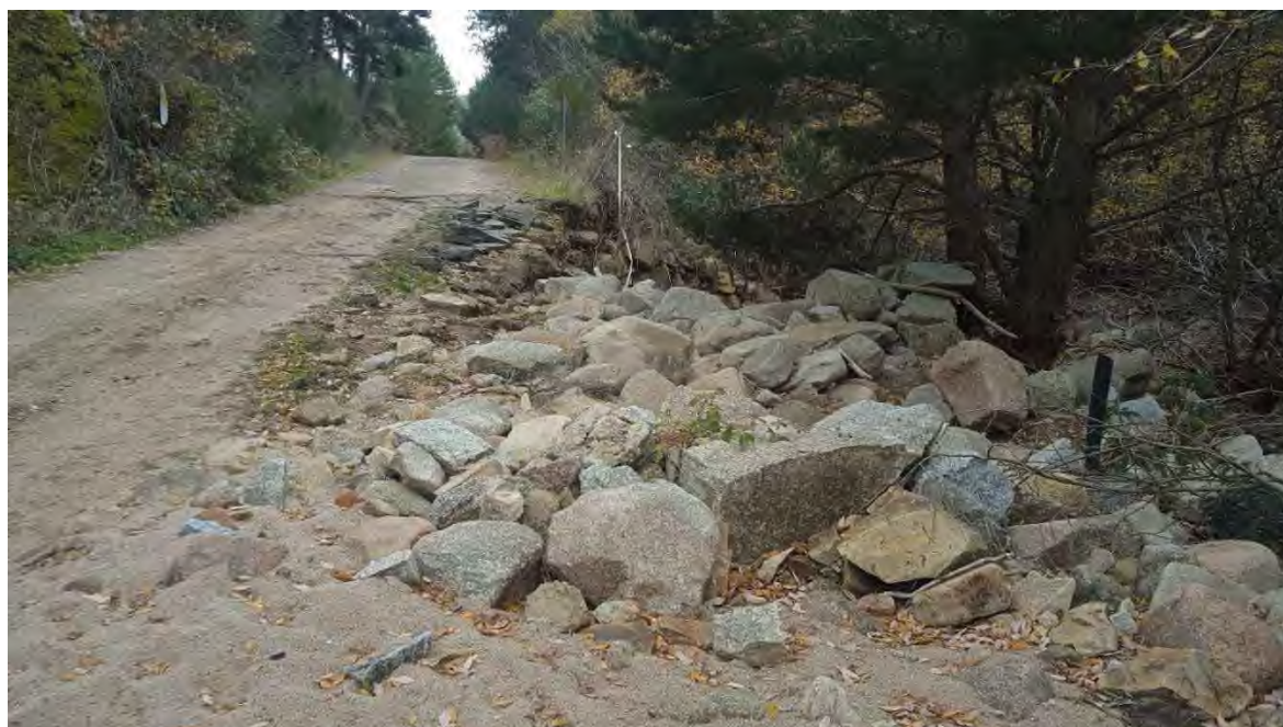
Camino perimetral aguas abajo del cruce sobre el arroyo Chubieco. Vista de la Margen izquierda desde el puente. Escollera de protección movilizada
