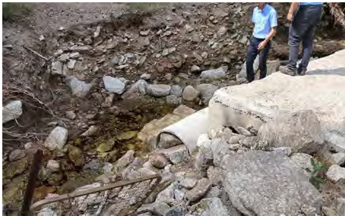
Figura 5. Estado actual de la obra de drenaje transversal del arroyo Navaluera.
