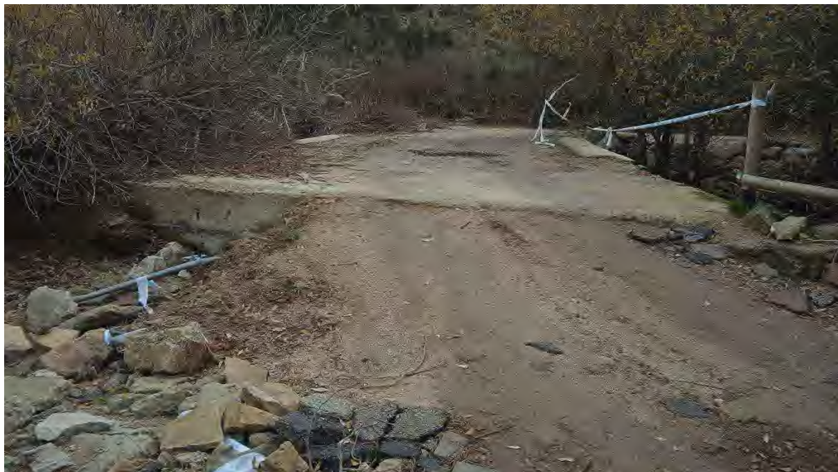
Vista de la erosión del camino en la margen derecha del arroyo Chubieco a la entrada del puente
