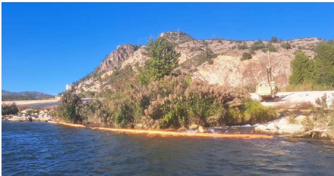
Imagen 10: Ejemplo de uso de barreras de contención
