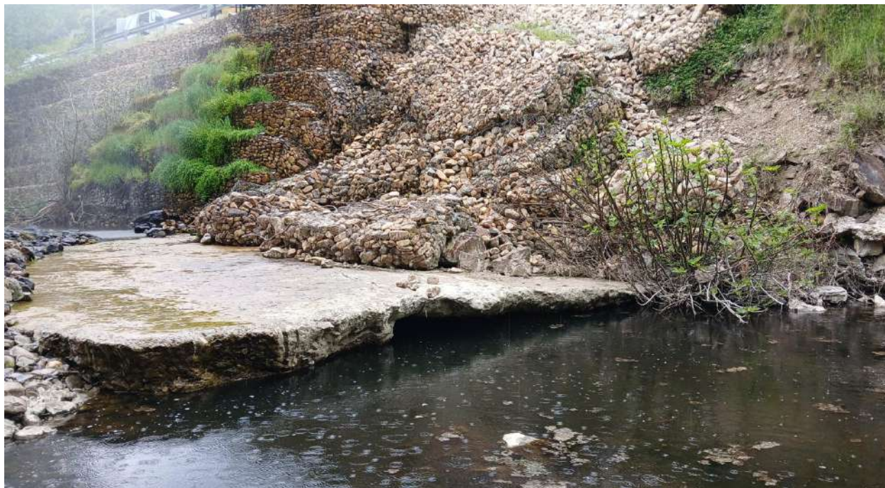
Imagen 5: Pie del talud con el muro de gaviones desprendido en la presa de Pedrezuela
