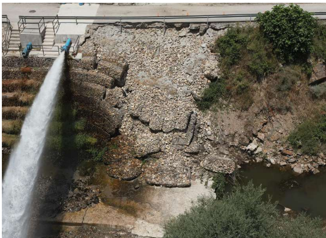
Imagen 4: Desprendimiento ocurrido en la presa de Pedrezuela
