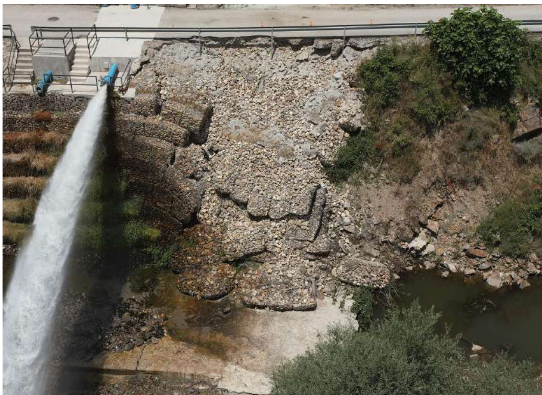
Imagen 1: Situación del desprendimiento visto desde vuelo con dron
