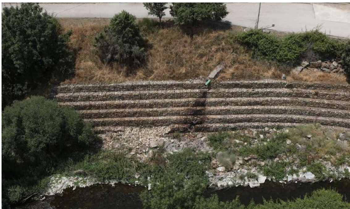
Imagen 3: Vista del muro de gaviones a lo largo del talud
