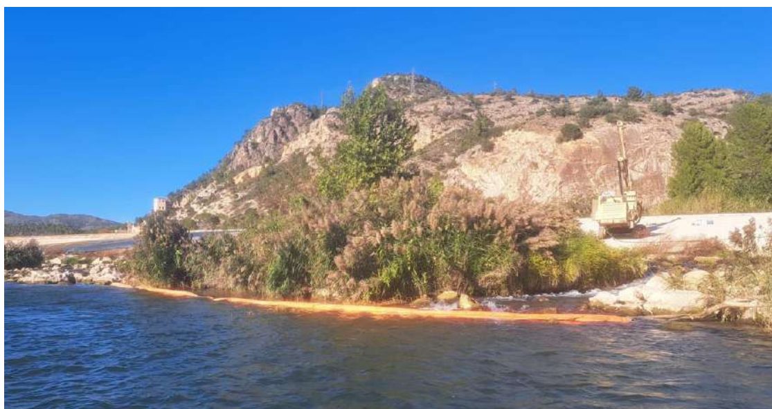
Figura 4: Ejemplo de uso de barreras de contención
