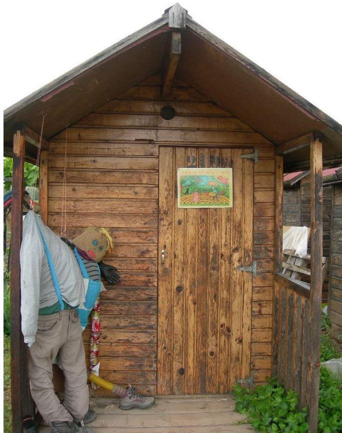
Imagen nº 1: Fachada de caseta de madera existente
