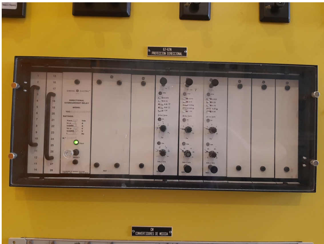
PROTECCIÓN DIRECCIONAL LÍNEA FUENCARRAL
