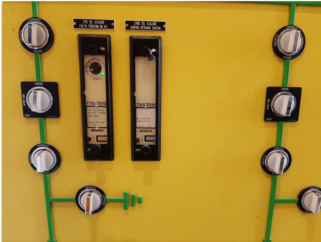
RESTO DE PROTECCIONES LÍNEA EL ATAZAR
