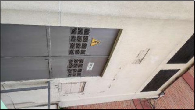
REVESTIMIENTO COTETERM EN MAL ESTADO.
