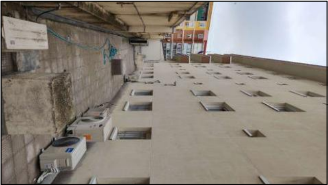
REVESTIMIENTO COTETERM EN MAL ESTADO. ENCUENTRO SATE CON SOLADO PATIO CALLE A ARCHIVO
