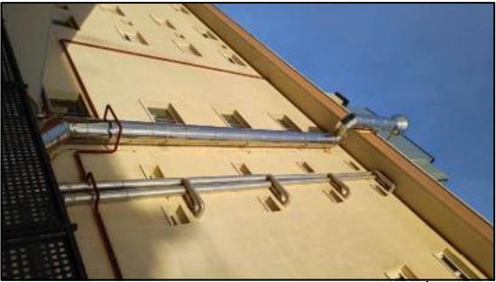
REVESTIMIENTO COTETERM CON AISLANTE EN MAL ESTADO. ENCUENTRO CON NUEVA CHIMENEA DE COCINA.
