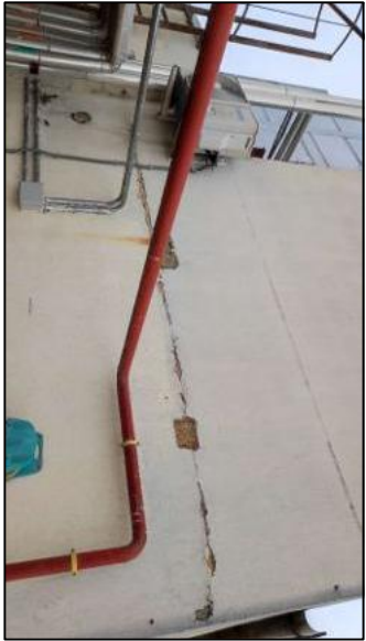
REVESTIMIENTO COTETERM EN MAL ESTADO.
