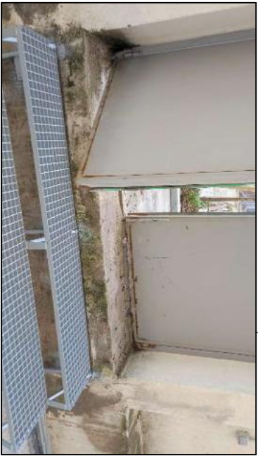
SOLADO EXTERIOR SIN CONTINUIDAD EN PELDAÑO
