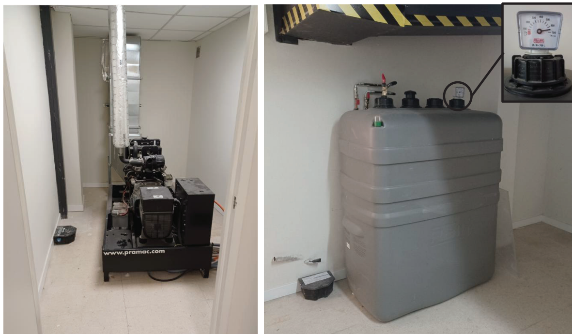
Ilustración 2. Grupo electrógeno actual y depósito de combustible
