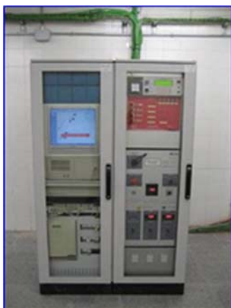
Figura 5 - Cuadros control extinción y equipos integración
