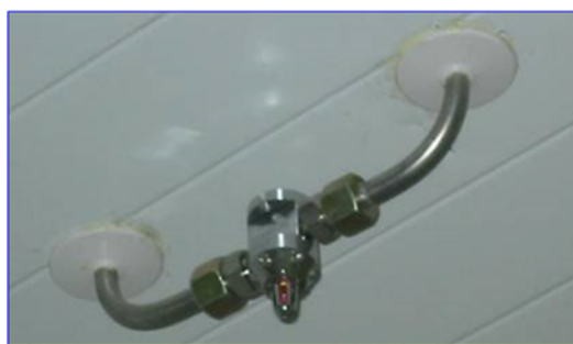
Figura 20 - Boquilla mixta
