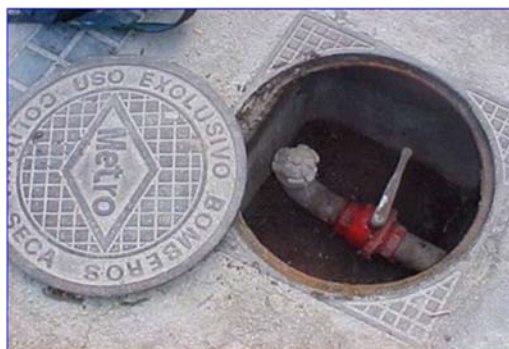
Figura 25 - Válvula corte alimentación
