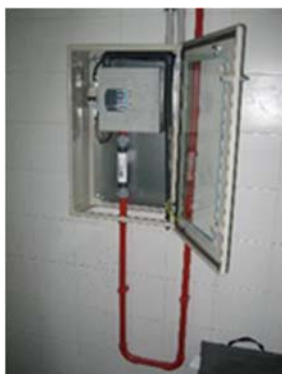
Figura 4– Detector Vesda láser compact
