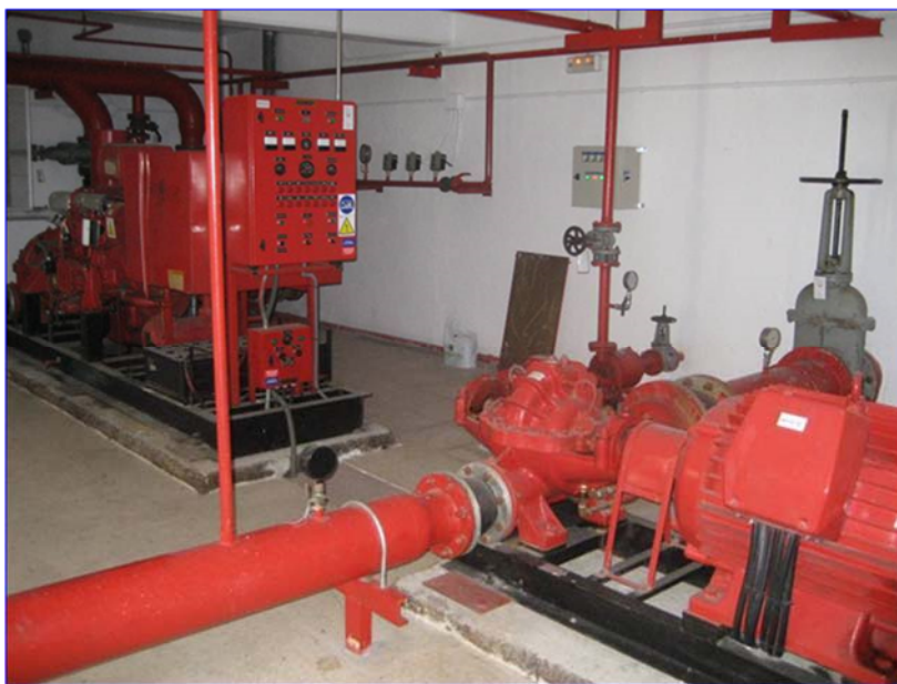
Figura 53 - Grupo eléctrico y grupo diésel principales
