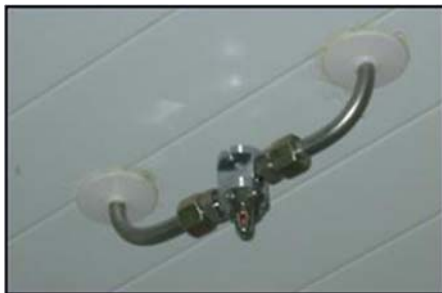
Figura 9 - Boquilla mixta
