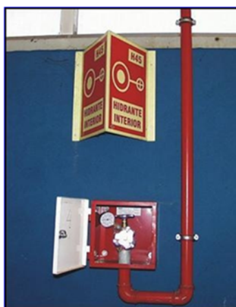
Figura 55 - Hidrante interior
