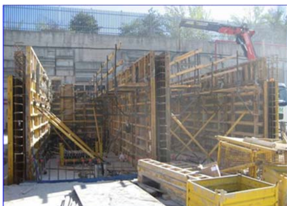
Figura 51 - Aljibe en construcción
