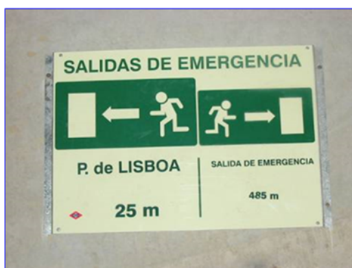
Figura 46 - Cartel foto luminiscente de túnel
