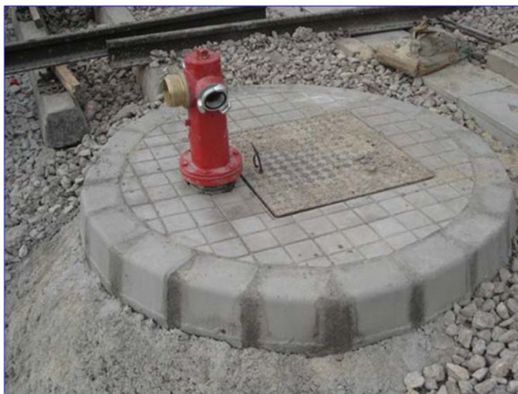
Figura 54 - Hidrante exterior de columna seca
