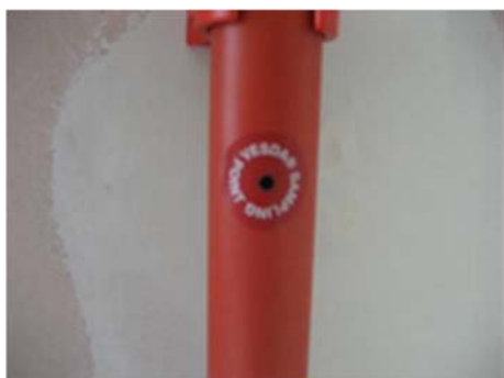
Figura 2– Orificio de aspiración
