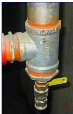
Figura 31- Válvula vaciado 1"
