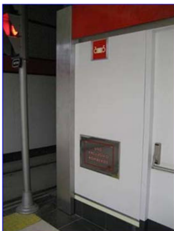
Figura 26 - Tapa acero inoxidable situado en piñón
