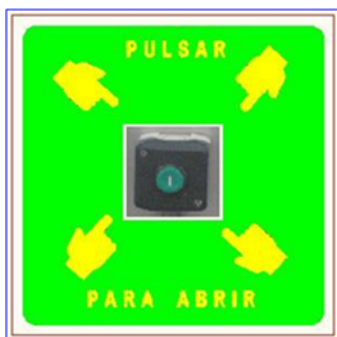
Figura 44 - Detalle cartel fotoluminiscente en pulsador
