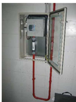
Figura 4– Detector Vesda láser compact
