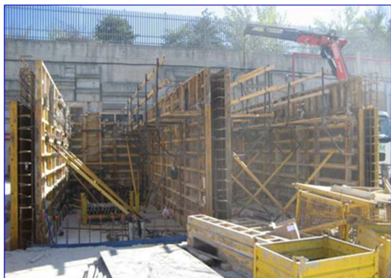
Figura 28 - Aljibe en construcción
