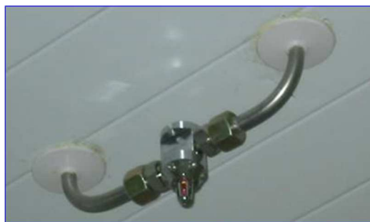
Figura 20 - Boquilla mixta
