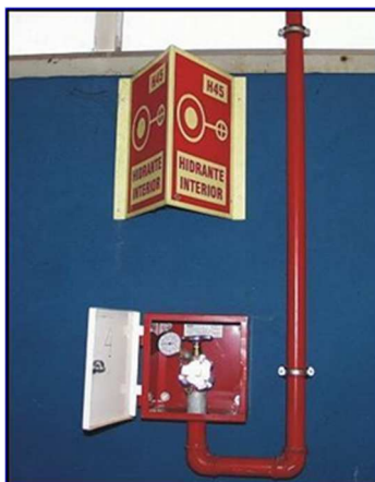
Figura 32 - Hidrante interior
