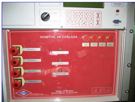
Figura 21 - Panel maestro extinción
