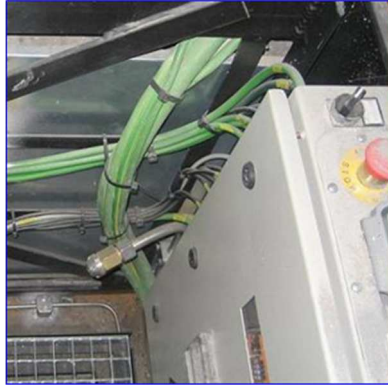
Figura 7 - Boquilla abierta foso escalera mecánica
