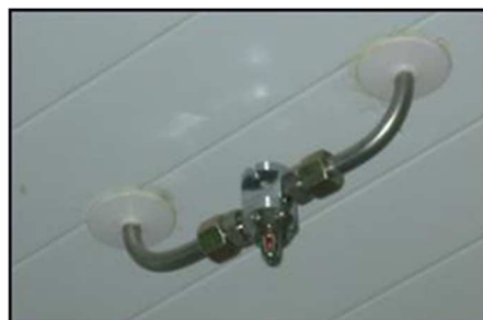
Figura 9 - Boquilla mixta
