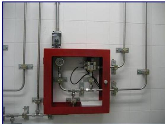
Figura 23 - válvula NS12 extinción cuarto técnico
