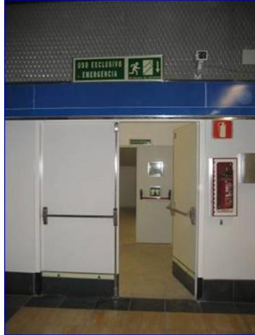
Figura 24 - Balizamiento fotoluminiscente en salida de emergencia de estación
