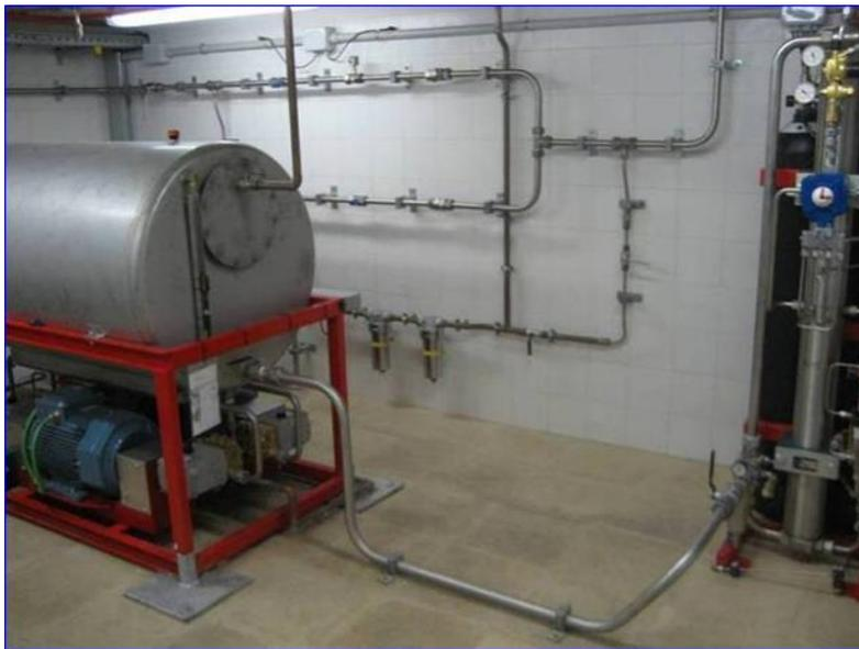
Figura 10 - Cuarto PCI extinción. Cuba almacenaje de agua
