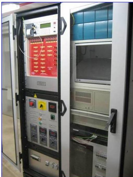
Figura 11 - Panel maestro extinción y cuadro eléctrico bombas
