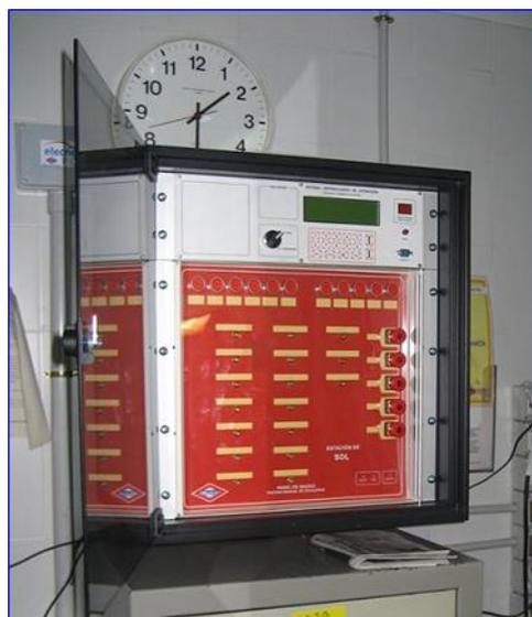
Figura 12 - Panel servidor extinción
