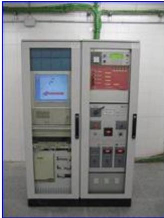
Figura 5 - Cuadros control extinción y equipos integración
