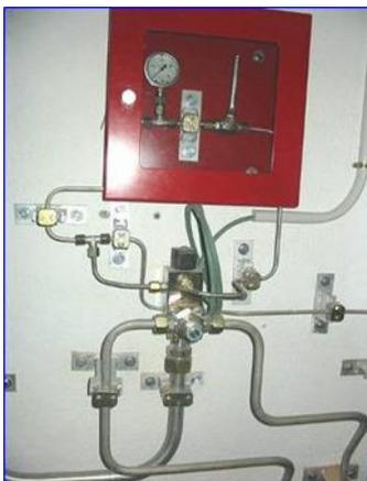
Figura 15 - Válvula extinción NS20 escalera mecánica
