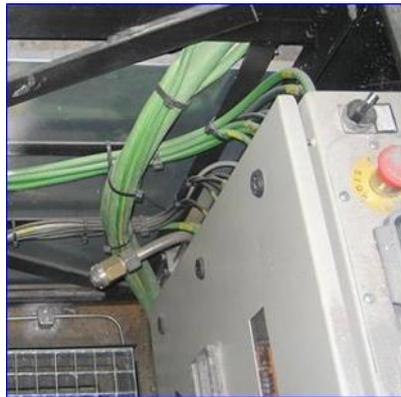
Figura 7 - Boquilla abierta foso escalera mecánica
