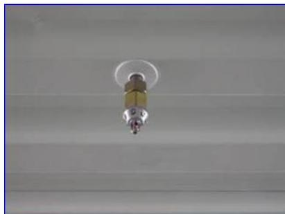
Figura 8 - Boquilla cerrada cuarto no técnico
