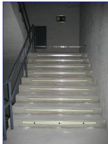
Figura 26 - Balizamiento foto luminiscente en interior salida de emergencia
