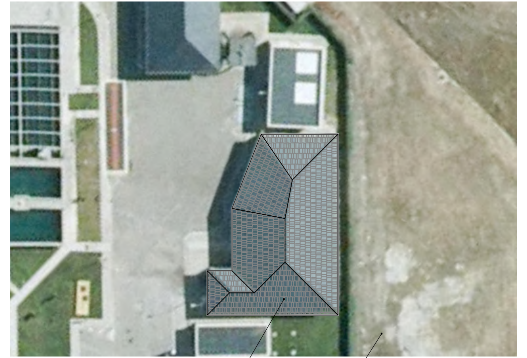
EDIFICIO DE REACTIVOS ZONA ETAP AMPLIADA
