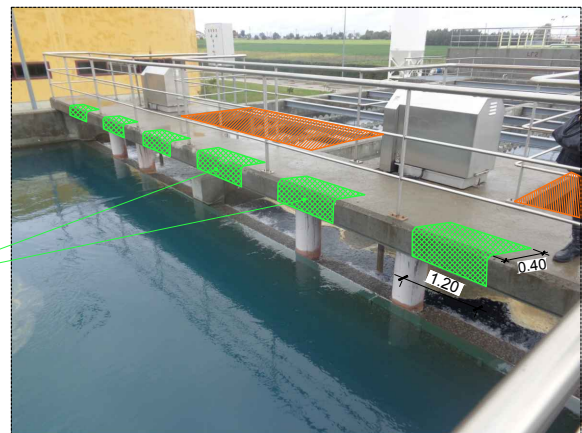
ACTUACIÓN 2.2 HUECOS EN PASARELA EXISTENTE DIM. 1.20x0.40m.
