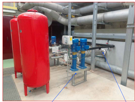
ACTUACIÓN 1. SITUACIÓN ACTUAL IMPLANTACIÓN GRUPOS DE PRESIÓN, AGUA DE SERVICIOS Y DILUCIÓN DE REACTIVOS.
