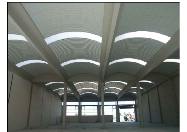
VISTA CUBIERTA INFERIOR
