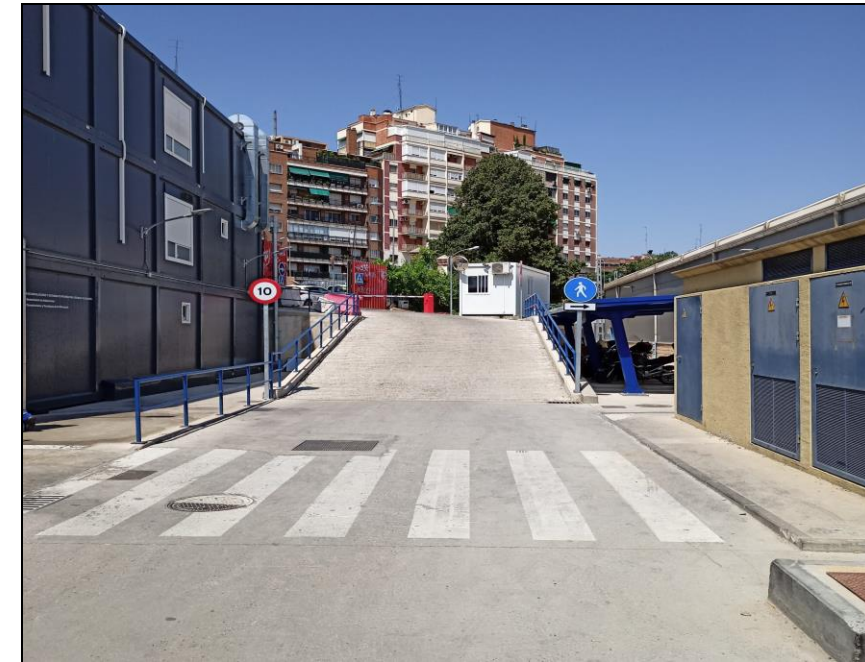
Rampa de ingreso de vehículos
