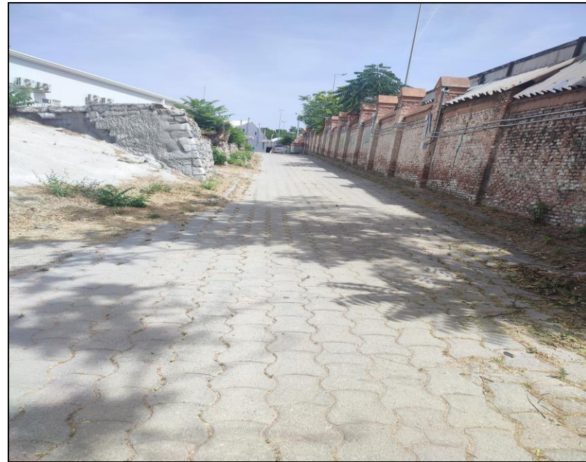
Zona de ATR y muros de contención
