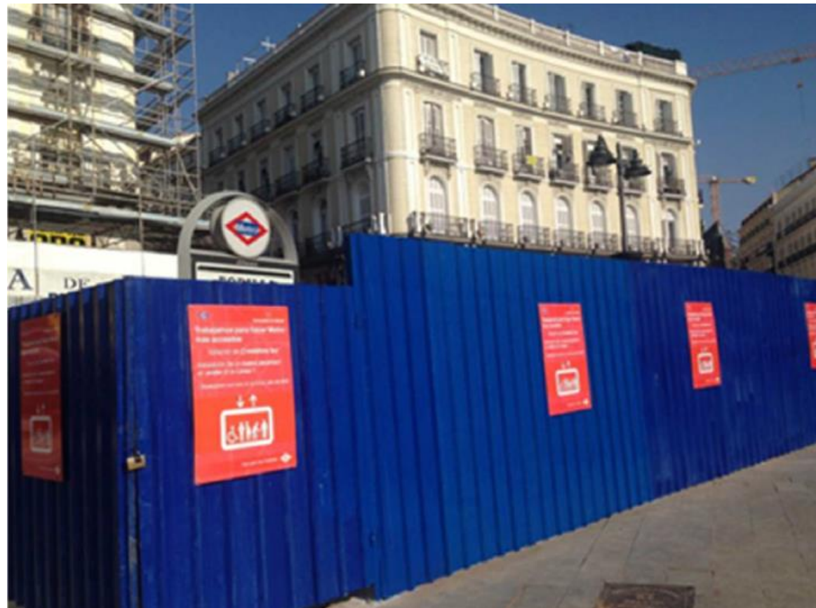
Ejemplo de cerramiento exterior
