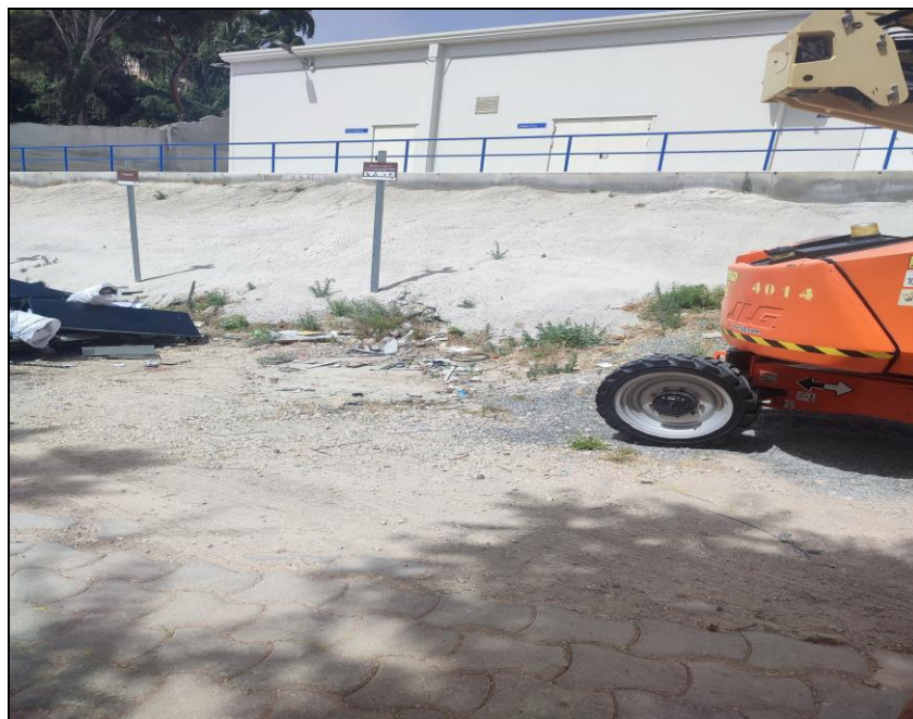
Taludes en zona de ATR
