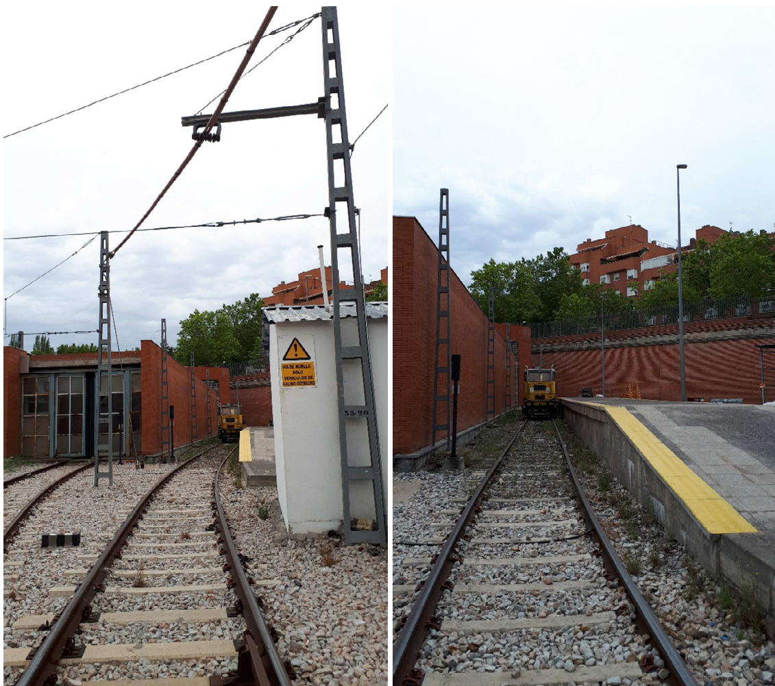
Figura 25. Detalle del estado actual de la vía de carga
