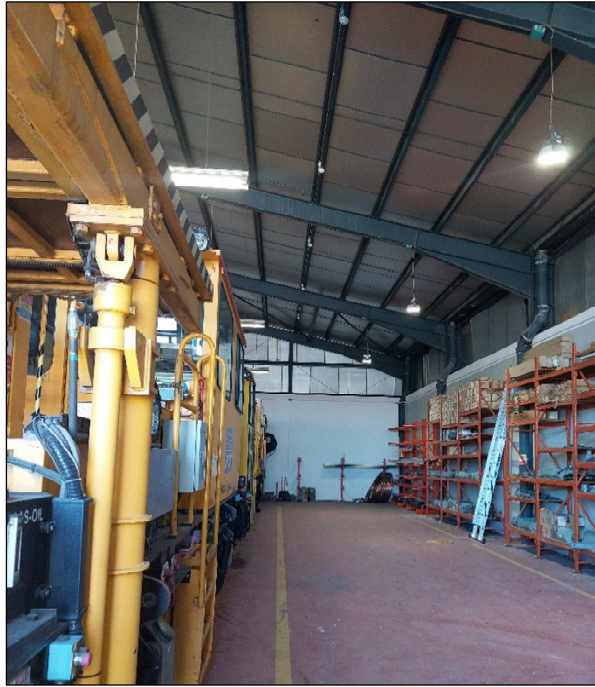
Figura 16: Estado actual Nave Mtto Línea Aérea Sacedal
