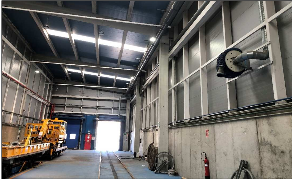
Figura 18: Estado actual Nave Mtto Línea Aérea Valdecarros
