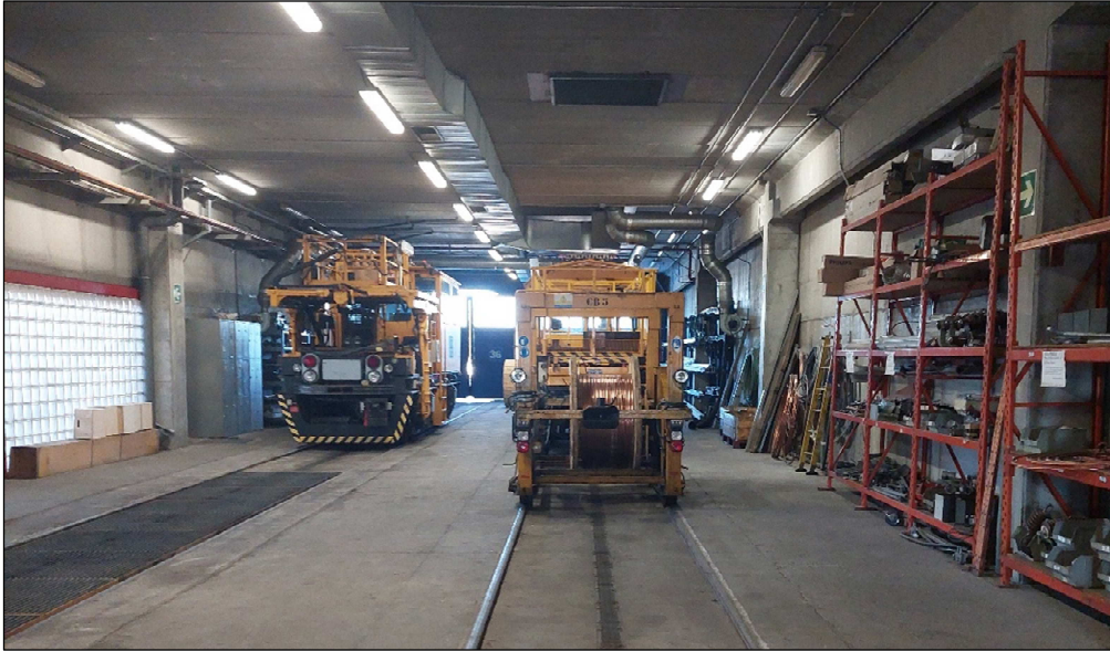
Figura 14: Estado actual Nave Mtto Línea Aérea Cuatro Vientos
