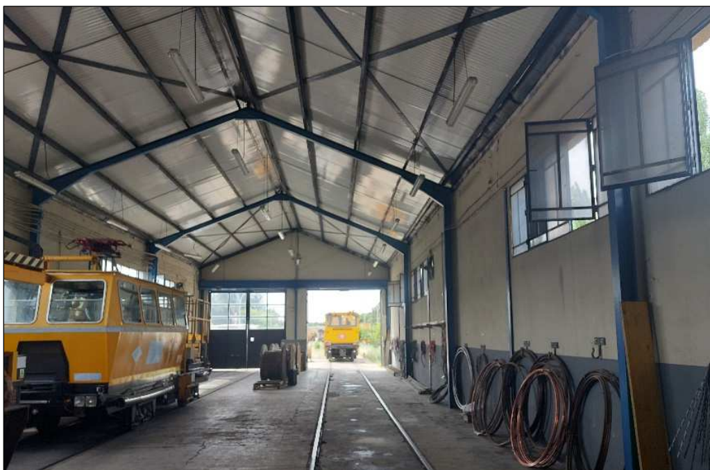
Figura 13: Estado actual Nave Mttto Línea Aérea Canillejas
