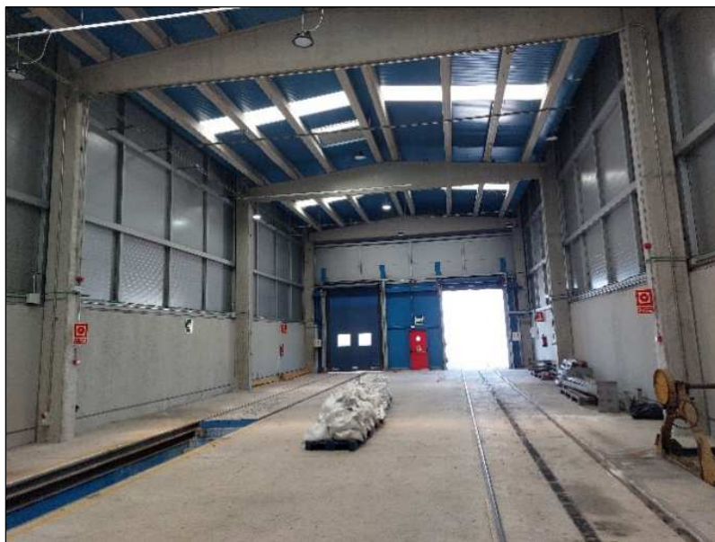
Figura 19: Estado actual Nave Mtto Línea Aérea Villaverde
