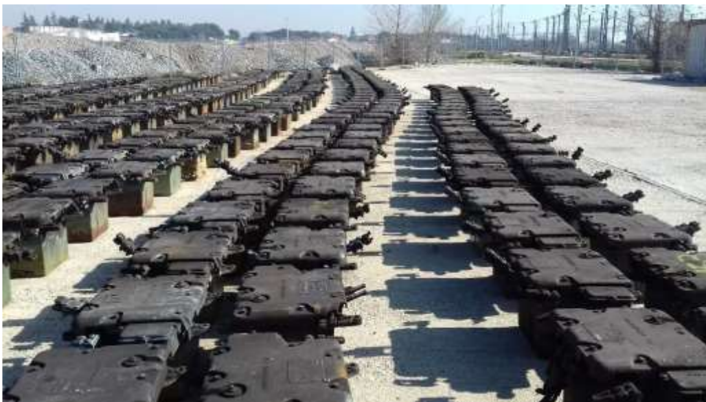
Ilustración 5 Ejemplo de disposición de juntas inductivas en la zona delimitada para su acopio
