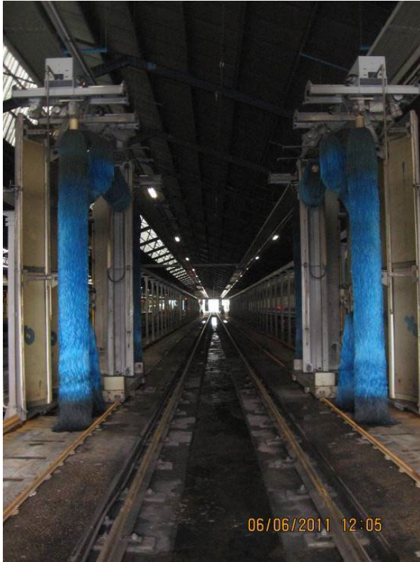
CANILLEJAS: Túnel de lavado CRHIST y recicladora
