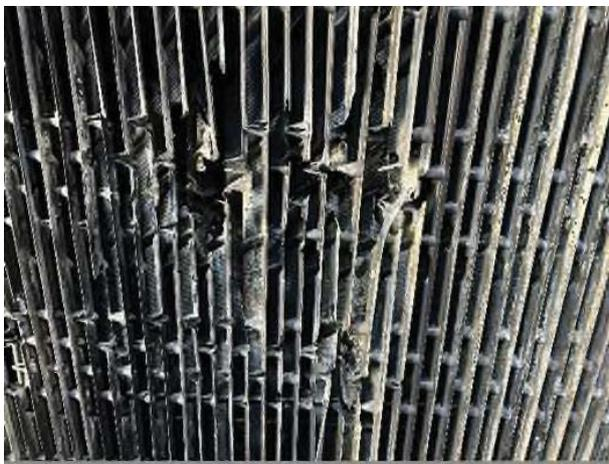
Un pack de relleno dañado dará como resultado una reducción de la capacidad. Las láminas de relleno dañadas tendrán un menor rendimiento de transferencia de calor en comparación con las hojas de relleno que hayan quedado intactas. El mayor esfuerzo que se aplica a las láminas de relleno restantes podría provocar que también fallen otras láminas de relleno.
