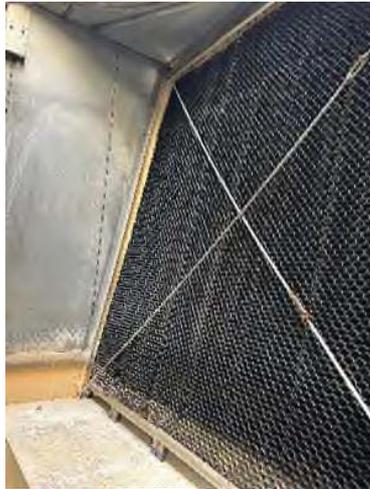
El relleno instalado en esta torre no cumple con la actual normativa en cuanto a eficiencia de los eliminadores de gotas al no disponer de estos elementos.
