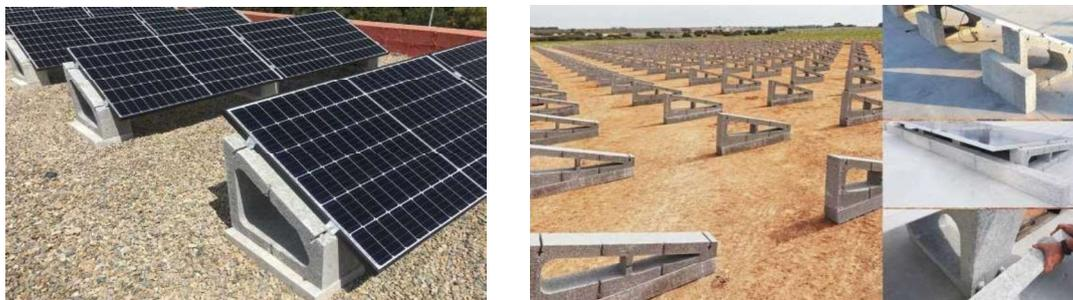
Estos lastres de refuerzo se colocan en la base de los soportes cuando se necesita ganar altura o por la parte trasera para potencia su eficacia y rigidizar la instalación en determinadas situaciones.
