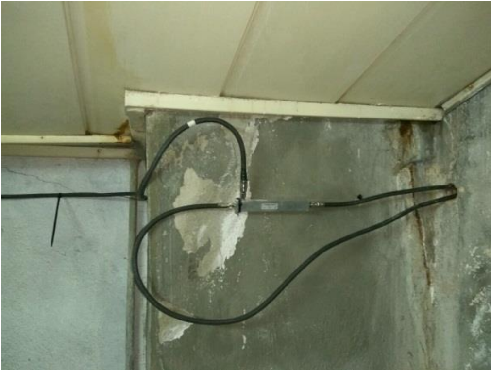
Figura 4: Instalación de acoplador de 10 dB en interior de salida de emergencia
