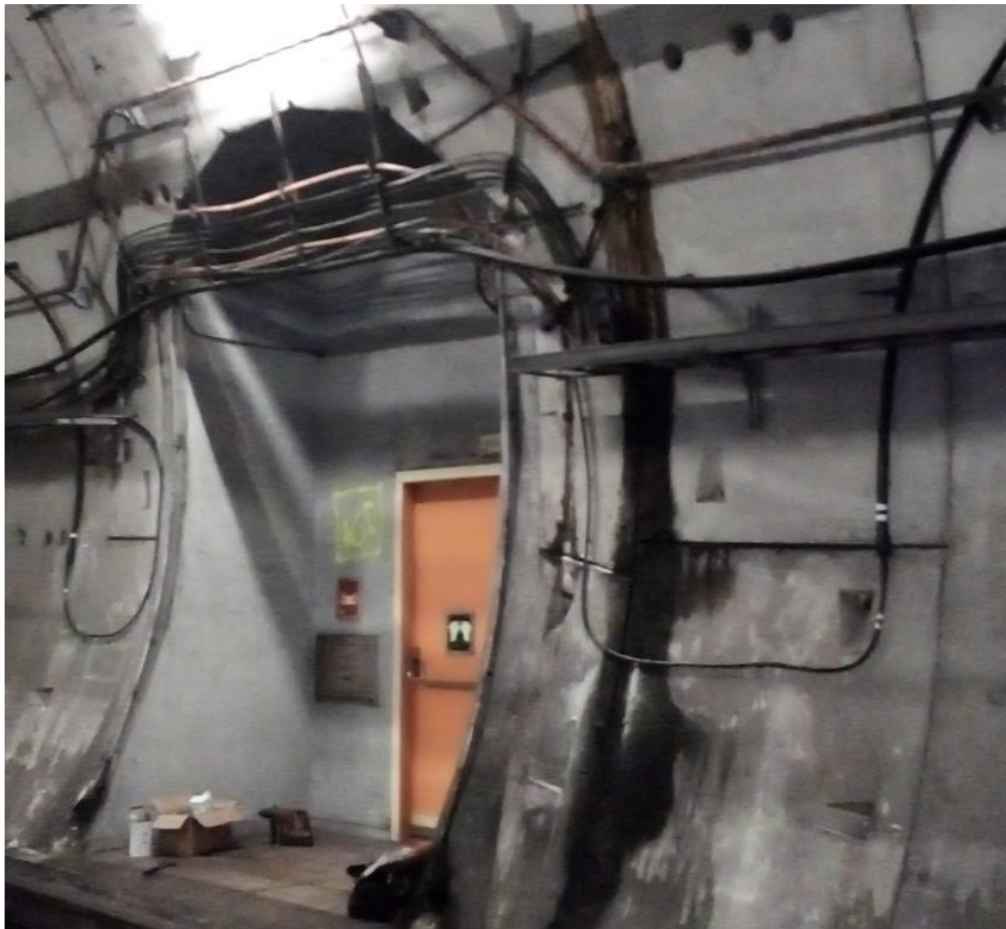
Figura 3: Bajada del cable radiante de línea a altura de trabajo para la conexión del sistema radiante de la salida de emergencia de túnel
