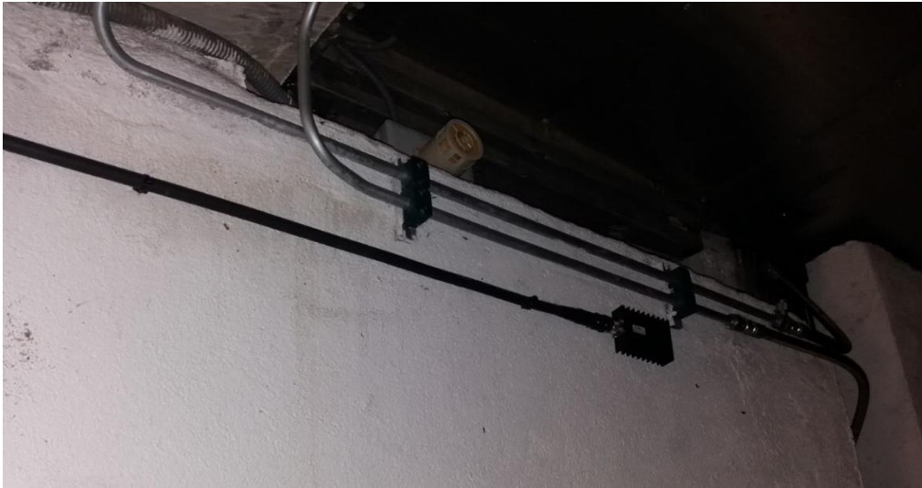
Figura 6: Instalación de carga en extremo final de salida de emergencia de túnel
