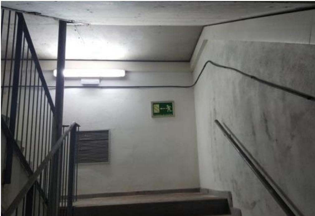
Figura 5: Instalación de cable radiante en perimetral de escalera de salida de emergencia
